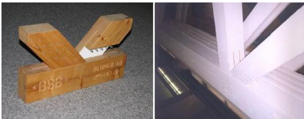
Obrázek 20 Příhradový vazník s ocelovými kolíky
