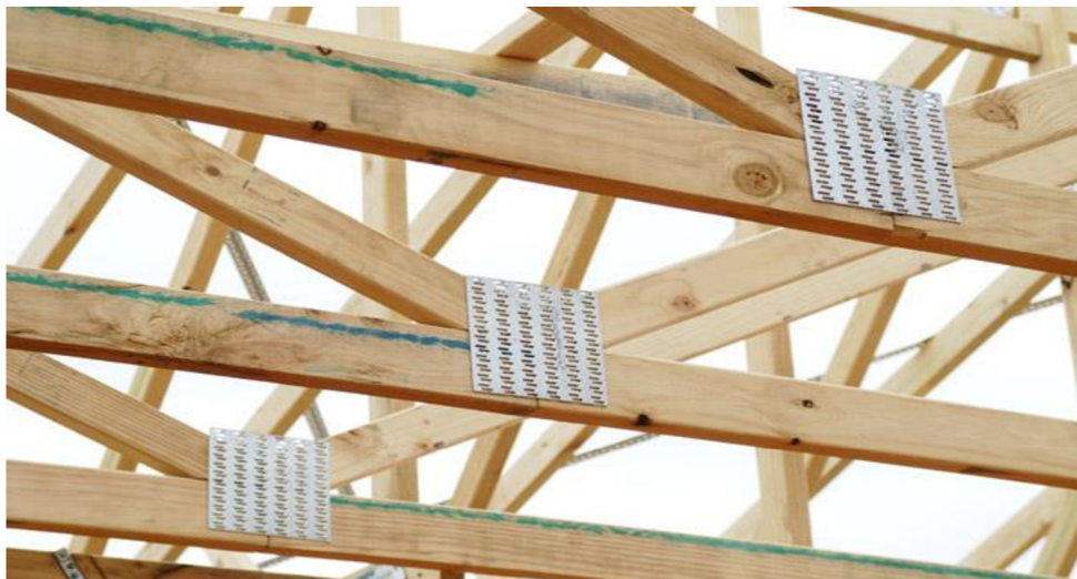
Obrázek 2 Zobrazení konkrétních styčnickových desek
