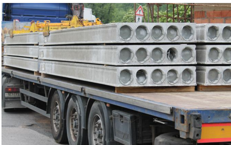
Obrázek 92: 12.5.5 - Doprava střešních panelů Spiroll administrativy
