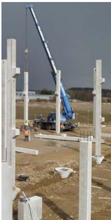
Obrázek 85: 12.5.1 - Montáž sloupů
