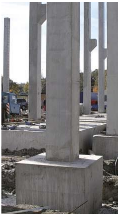
Obrázek 86: 12.5.2 - Zmonolitnění sloupů se základovými kalichy
