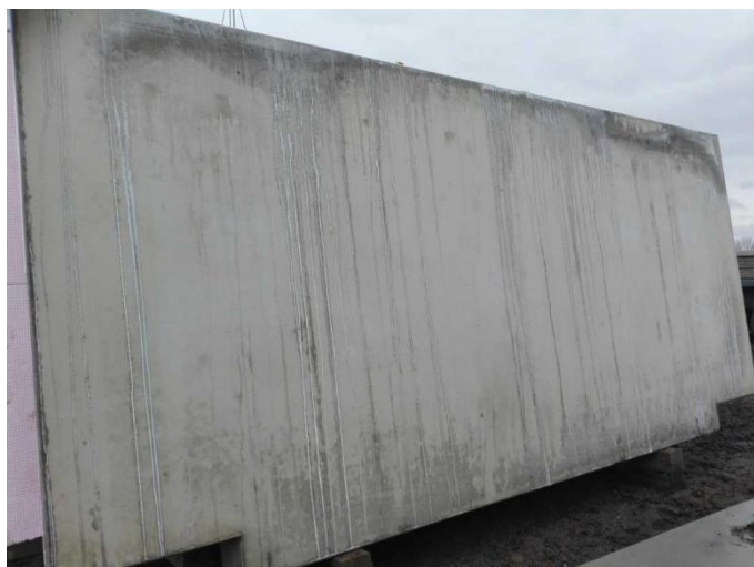
Obrázek 88: 12.5.3.2 - Montáž plných stěn
