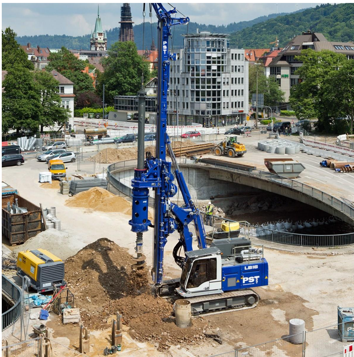
Obrázek 23: 7.1.5 - Pilotovací souprava Liebherr 16-180
