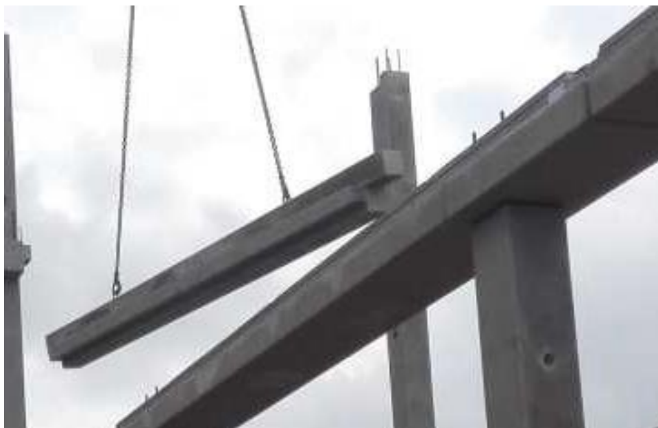
Obrázek 90: 12.5.4.1 - Montáž obvodových a středových ztužidel
