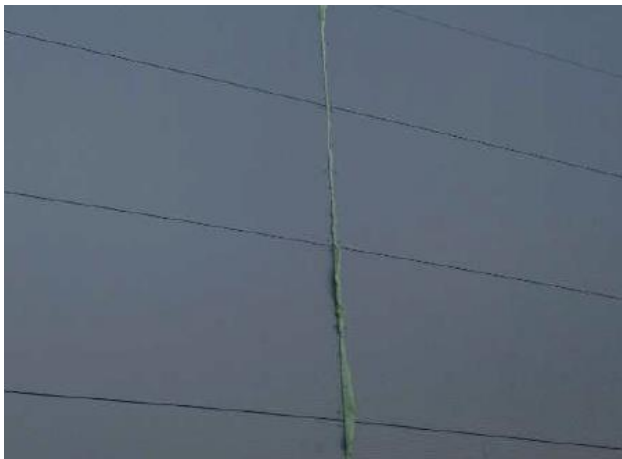
Obrázek 103: 13.5 - Vyplnění vertikální spáry PUR pěnou
