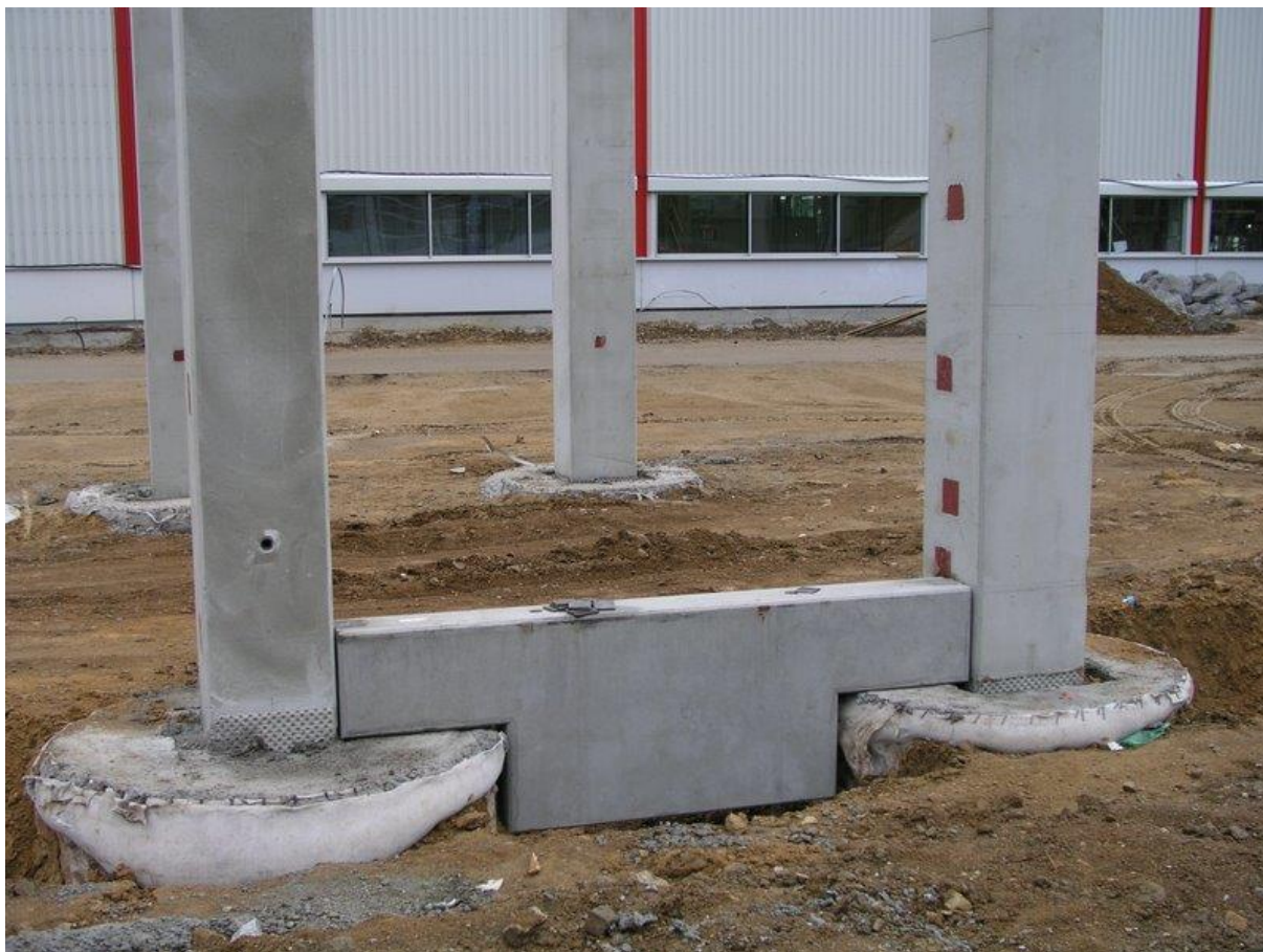
Obrázek 87: 12.5.3.1 - Montáž základových prahů a jejich přivaření k ocelovým destičkám na sloupech
