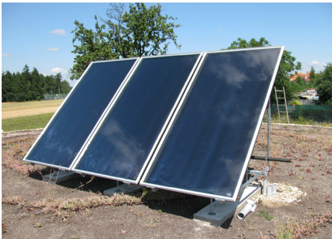
Obr. 50 - Solární termické kolektory SK 218 Freesun (foto autora)
