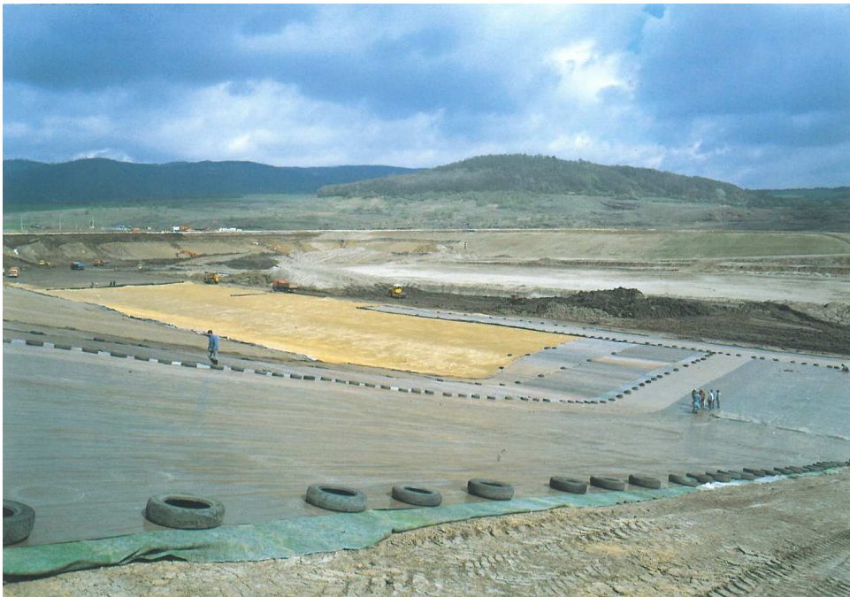
Obr. 27: Skládky průmyslových odpadů ve výstavbě
