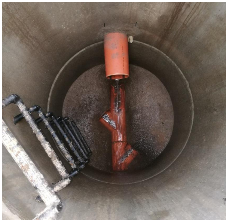
Obrázek 5 – Revizní šachta RŠ S2 na stoce S1, viz příloha č. 1
