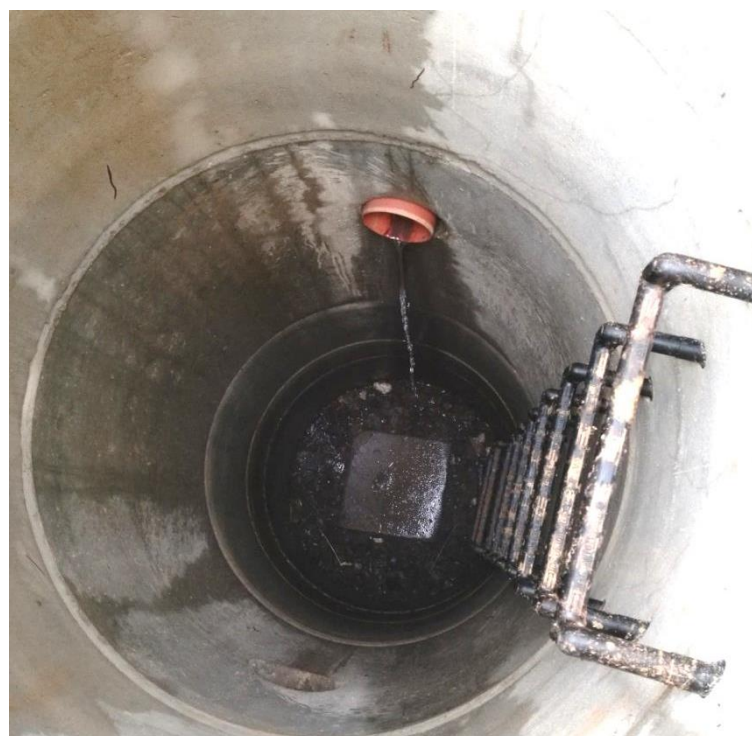
Obrázek 6 – Vyústění splaškové kanalizace do vsakovací studny
