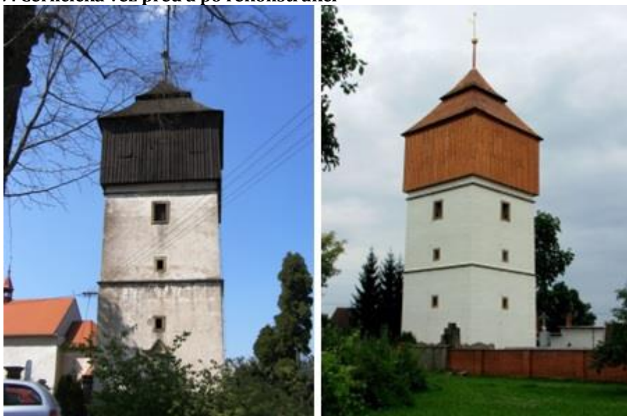
Obrázek 7: Černčická věž před a po rekonstrukci
