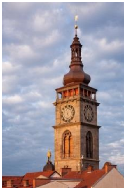
Obrázek 11: Bílá věž po rekonstrukci
