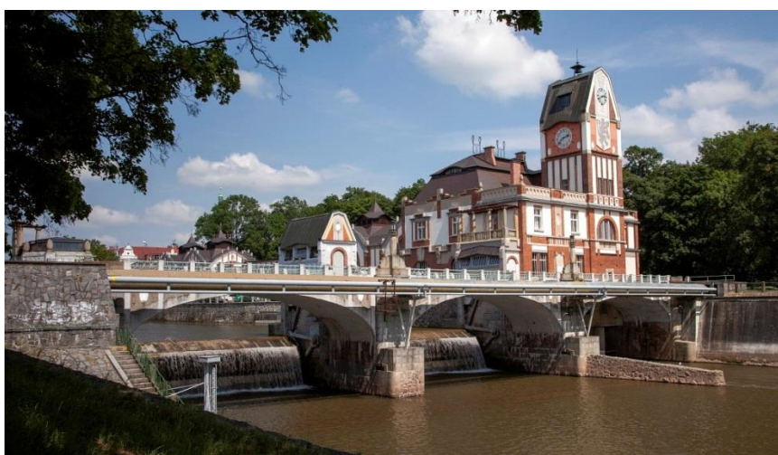
Obrázek 14: Labská vodní elektrárna „Hučák“
