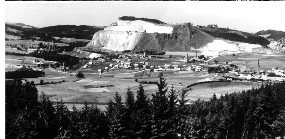
Obr. 23 postupující těžba pohled z Červeného kamene (zdroj: KOTOUČ ŠTRAMBERK, spol. s.r.o., 2017)
