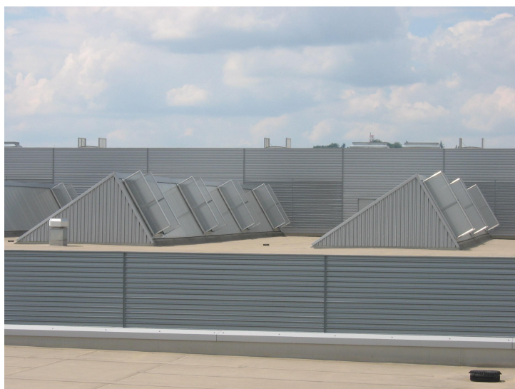
Foto 7 ó Klapky samo inného odv traciho za ízení
