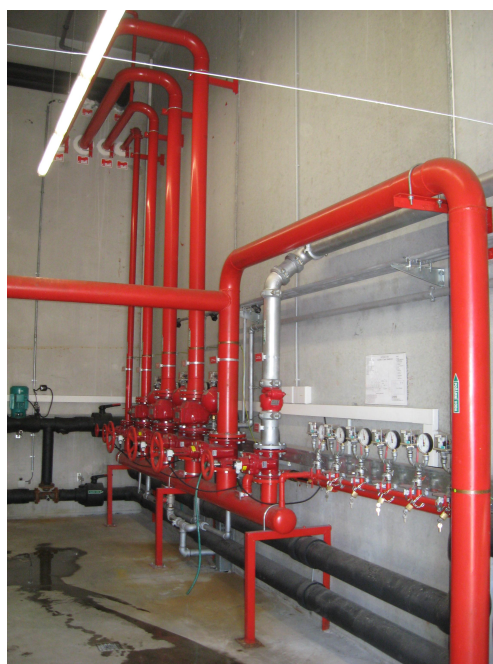
Foto 6 ó Strojovna samo inného stabilního hasičho za ízení
