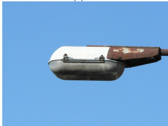
(14) Ulice Sokolovská (49.6003836N, 17.2667556E) Svítidlo v dezolátním stavu, takřka neprůhledný difuzor
