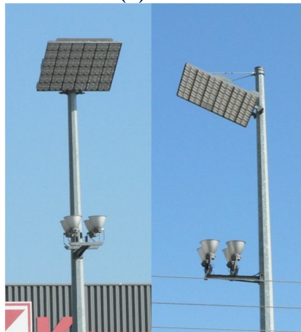
(8) Holice, sklad Kaufland (49.5646725N, 17.3066828E) Naprostě nevhodné osvětlení, světlo ze zdrojů je vyzařováno přímo do nebe, reflektor odráží sotva 50 % produkovaného světla, zbytek generuje světelné znečištění. Nad skladem jsou z dále vidět svítící mraky (není VO).
