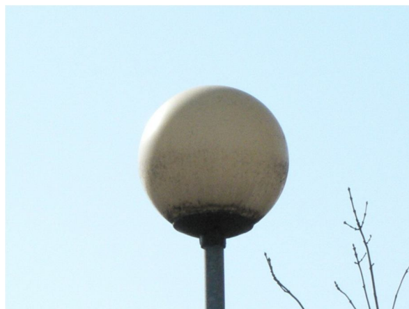
(18) Ulice 17. listopadu (49.5940392N, 17.2622819E) Klasická koule, 50 % světla vyzářováno do horního poloпростoru, stíní si pod tebe, využitelnost světla je pod 20 %
