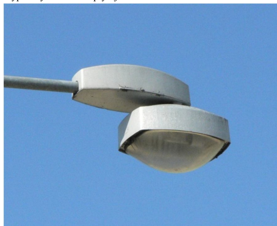
(4) Ulice Velkomoravská (49.5813492N, 17.2589069E) nejrozšířenější typ svítidla v soustavách VO v ČR (typ 444 23 15-17) 159
