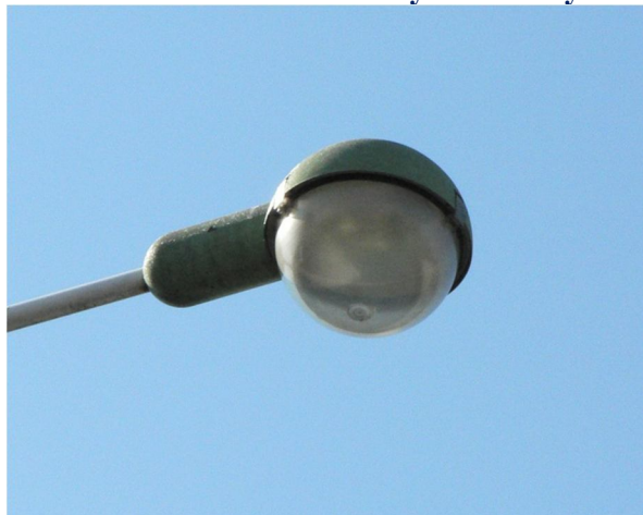
(7) Blíže neurčená ulice Difuzor svítidla 444 25 01 / 44 26 01 snižuje účinnost zdroje, šíří světlo do všech směrů
