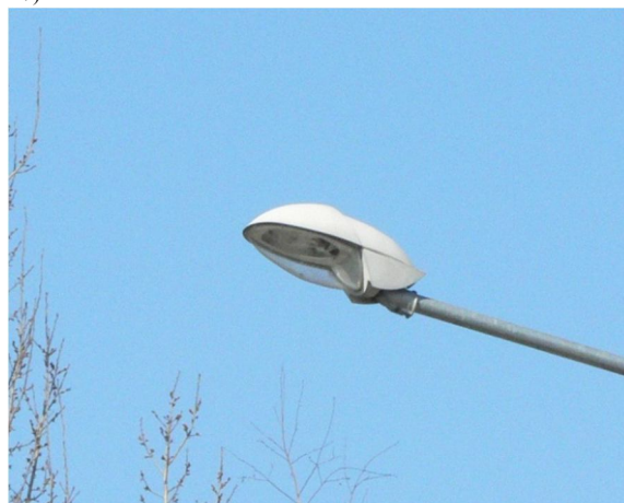
(6) Ulice Přerovská (49.5599567N, 17.3099456E)
