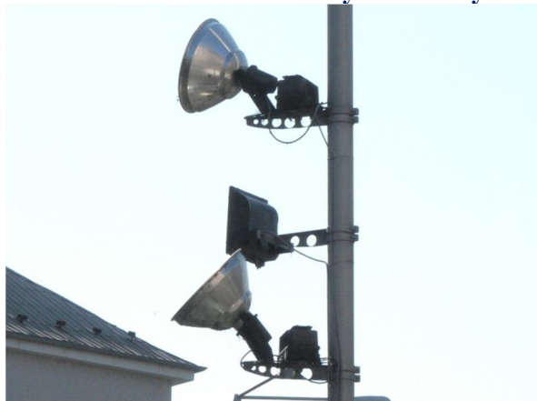
(13) Gorazdovo náměstí (49.5976906N, 17.2687689E) osvětlení Architektonické bez zastínění má výrazné světelné přesahy, ty svítí přímo do nebe
