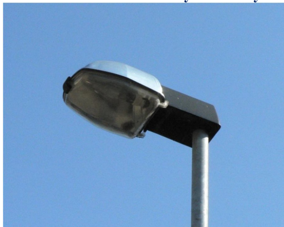
(1) Ulice U sokolovny (49.5532925N, 17.2509958E) Vypouklý difuzor rozptyluje světlo do oken domů.
