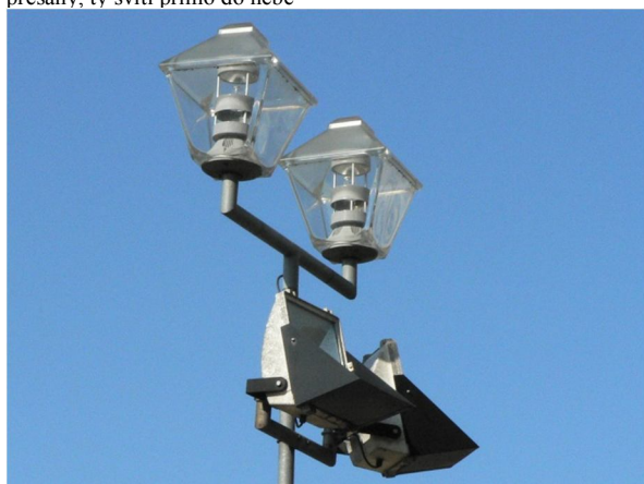
(15) Sušilovo náměstí (49.6063594N, 17.2643264E) Architektonické osvětlení stíněné pouze v dolním poloпростoru, výrazné světelné přesahy na oblohu oslňují z dálky více jak 4km
