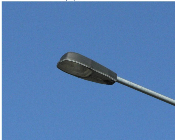
(8) Ulice Přerovská (49.5705486N, 17.3011778E) Osvětlení komunikace pouze s velmi málo vypouklým difuzorem
