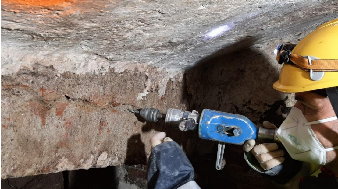
Obrázek 29, Provádění zkoušky Kučerovou vrtačkou pro zjištění pevnosti malty, na obrázku zkouška malty klenebného pásu [18].
