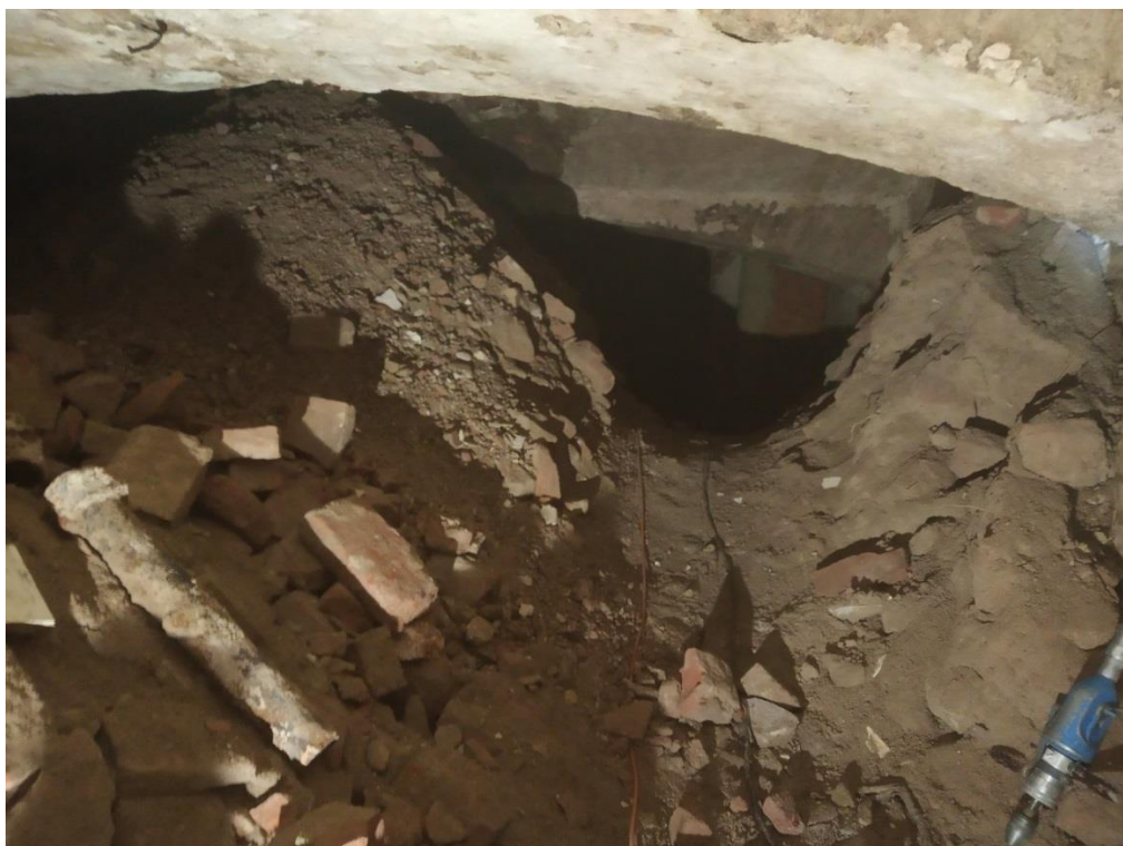
Obrázek 22, Pohled na částečně zasypané sklepní prostory [18].
