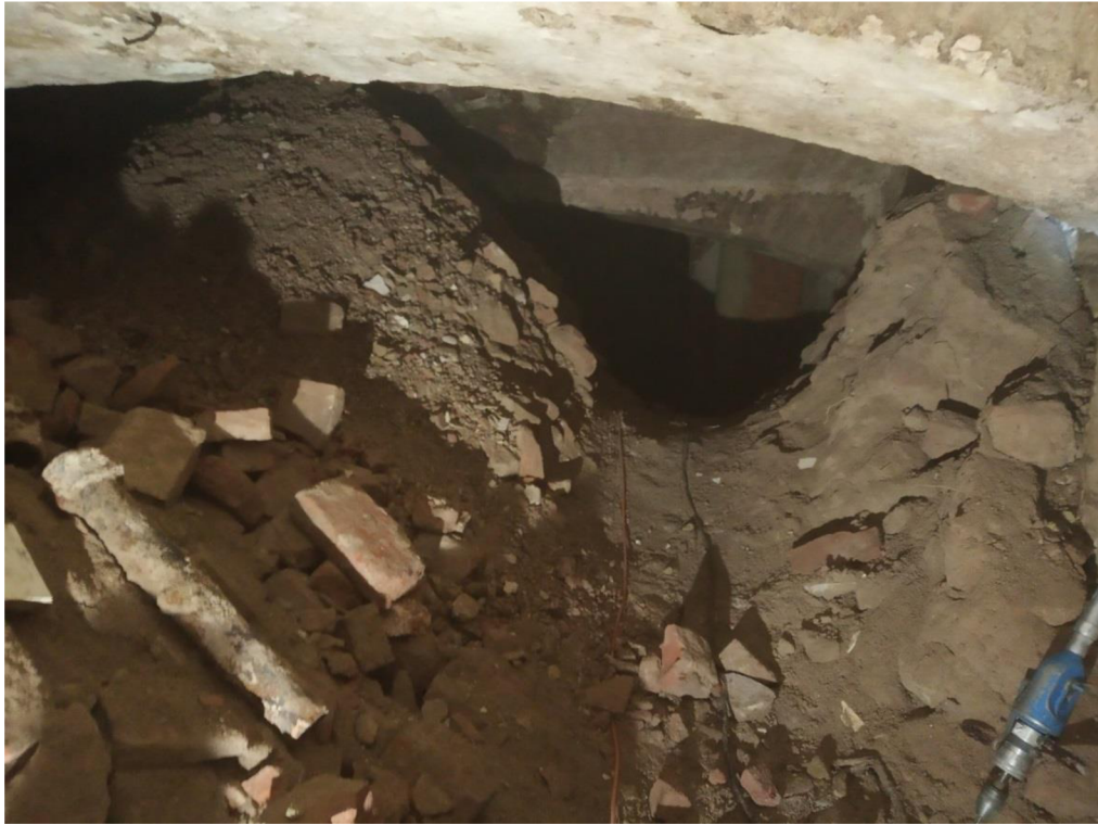
Obrázek 22, Pohled na částečně zasypané sklepní prostory [18].
