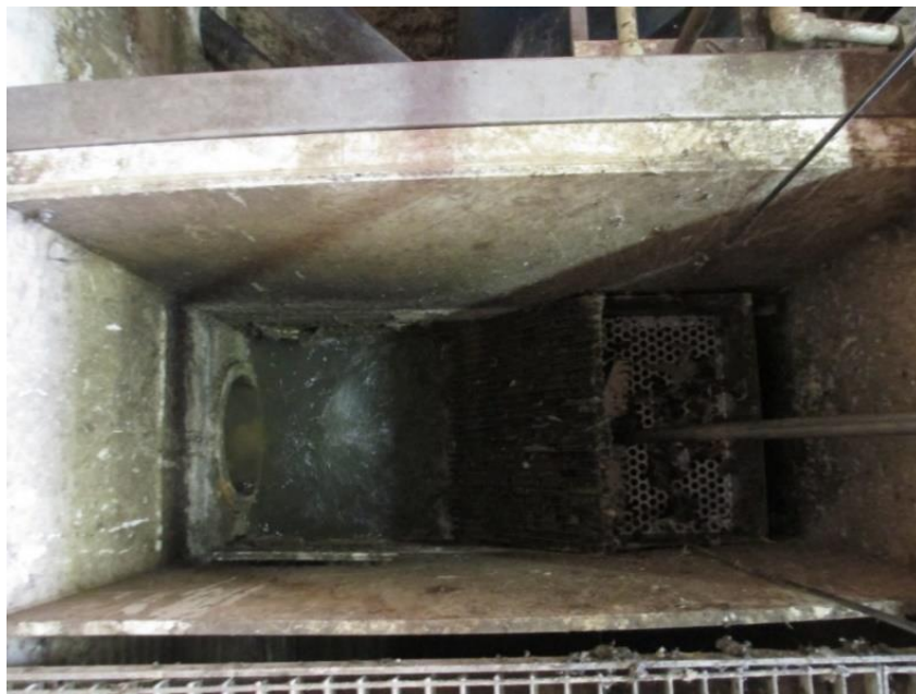
Obr. 3 Aktivační čistírna A: Hrubé česle
