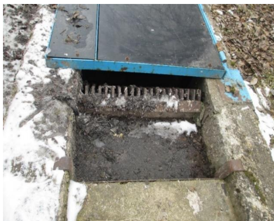
Obr. 7 Aktivační čistírna B: Hrubé česle
