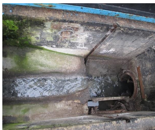
Obr. 8 Aktivační čistírna B: Lapák písku
