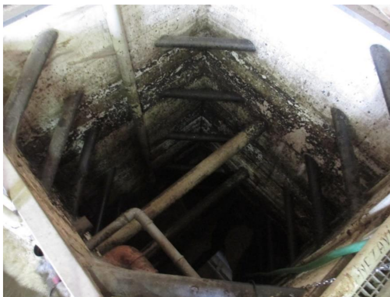
Obr. 6 Aktivační čistírna A: Uskladňovací nádrž na přebytečný kal
