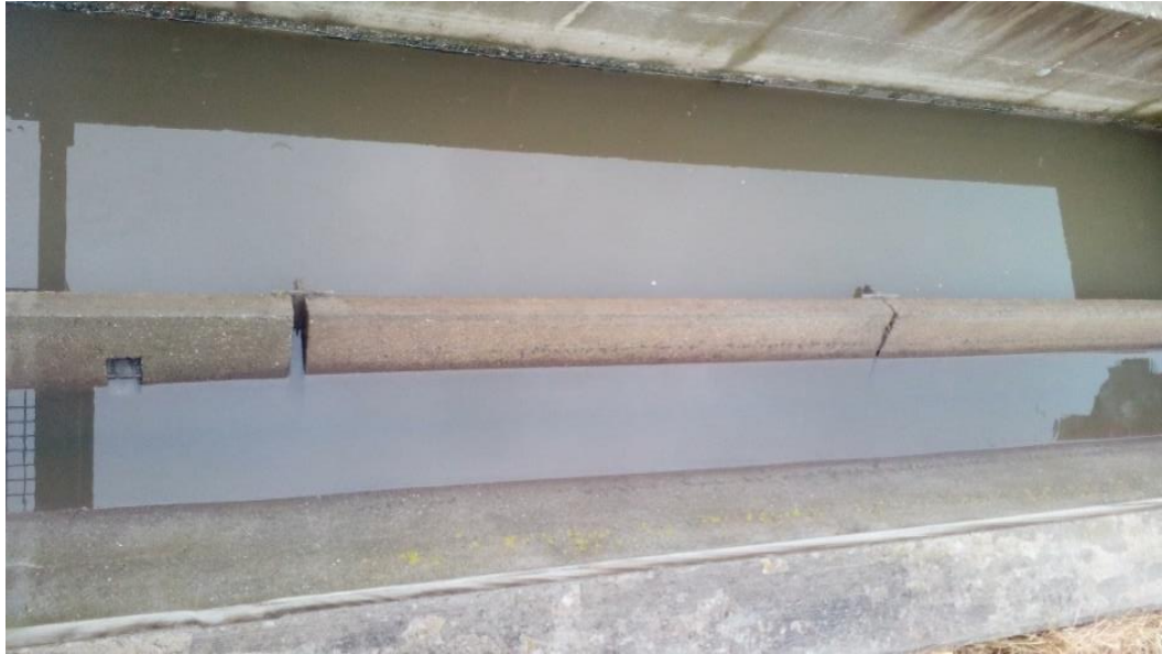
Obr. 12 Kořenová čistírna C: Lapák písku s horizontálním průtokem
