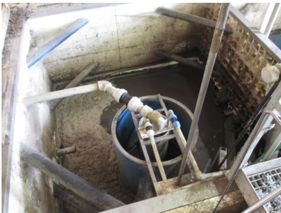
Obr. 4 Aktivační čistírna A: Lapák písku v dosazovací nádrži
