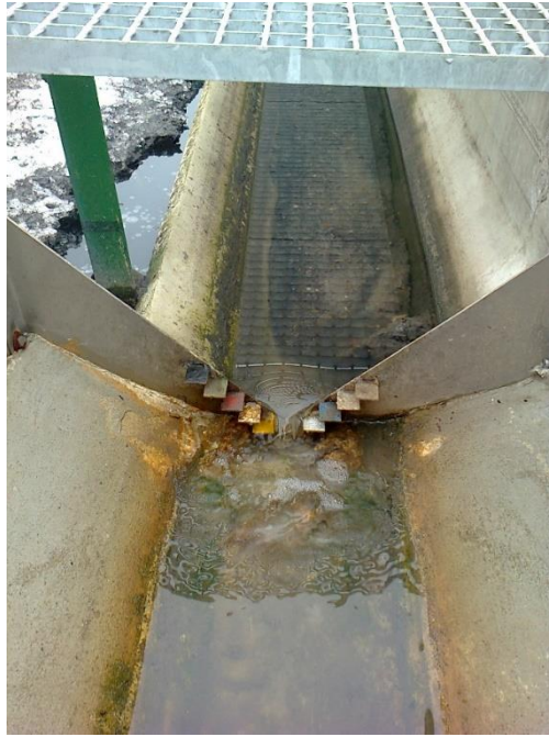
Obr. 16 Kořenová čistírna D: Lapák písku
