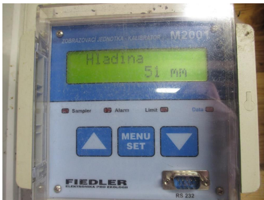
Obr. 4 Aktivační čistírna A: Zobrazovací jednotka připevněná na stěně objektu
