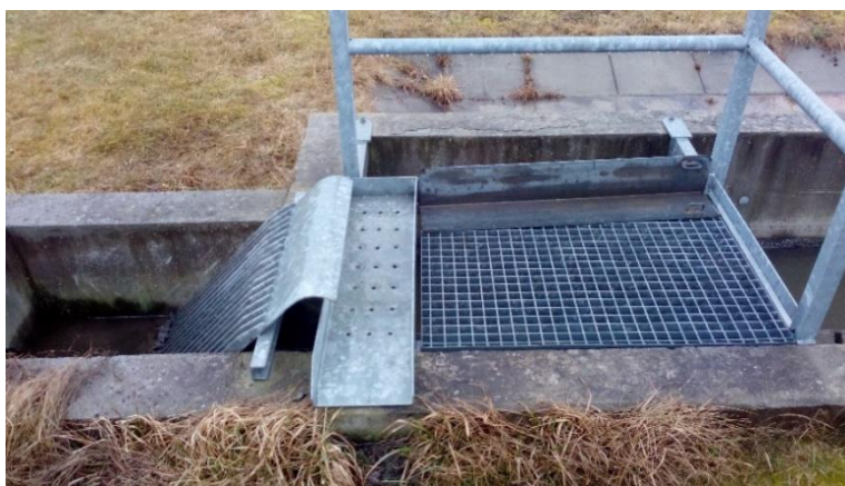
Obr. 11 Kořenová čistírna C: Hrubé manuální česle
