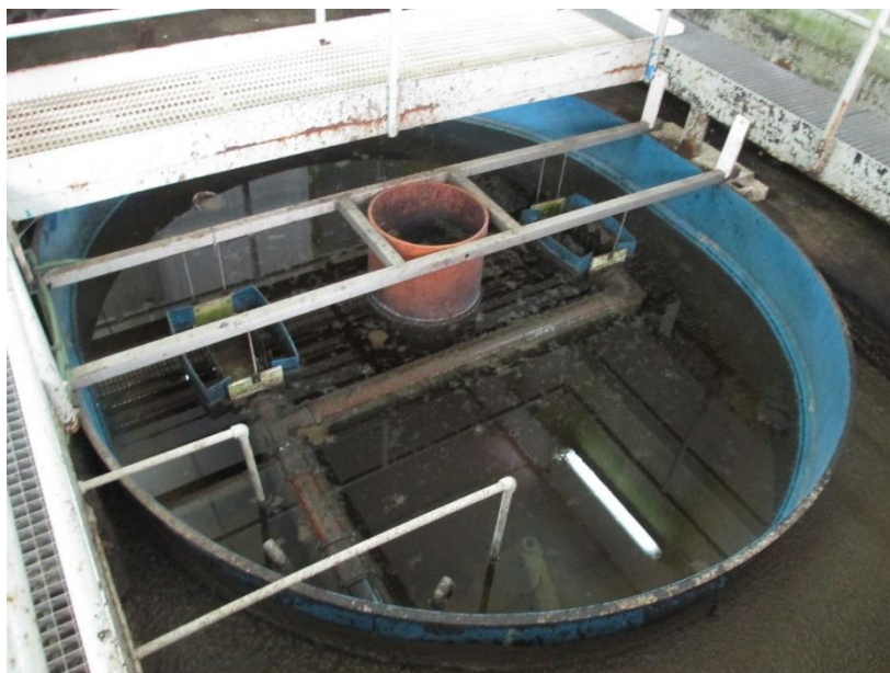
Obr. 9 Aktivační čistírna B: Kruhová dosazovací nádrž
