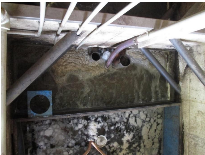
Obr. 5 Aktivační čistírna A: Aktivační proces se spuštěnou aerací
