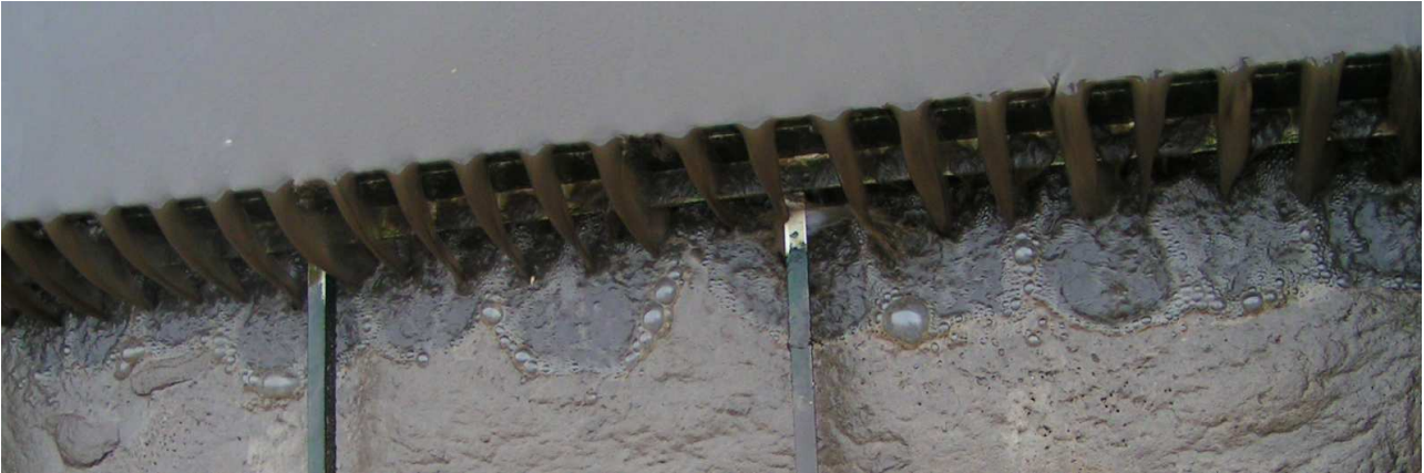
Obr. 3.3 Odtok z aktivací nádrže přes přelivnou hranu
