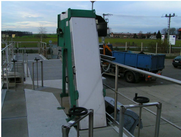
Obr. 2.2 Strojně stírané česle s kontejnerem na shrabky
