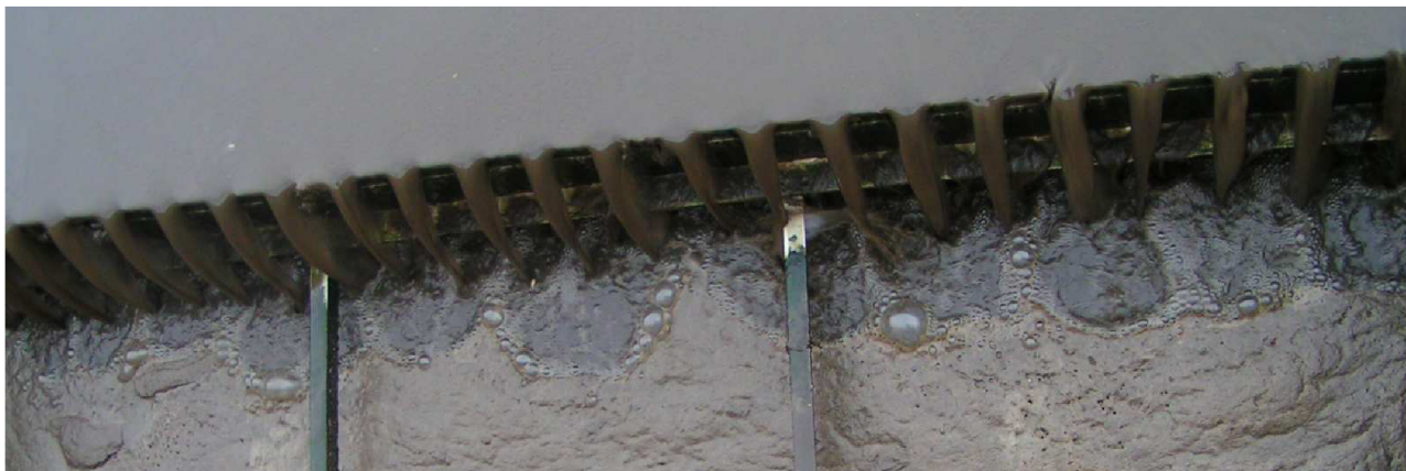
Obr. 3.3 Odtok z aktivací nádrže přes přelivnou hranu
