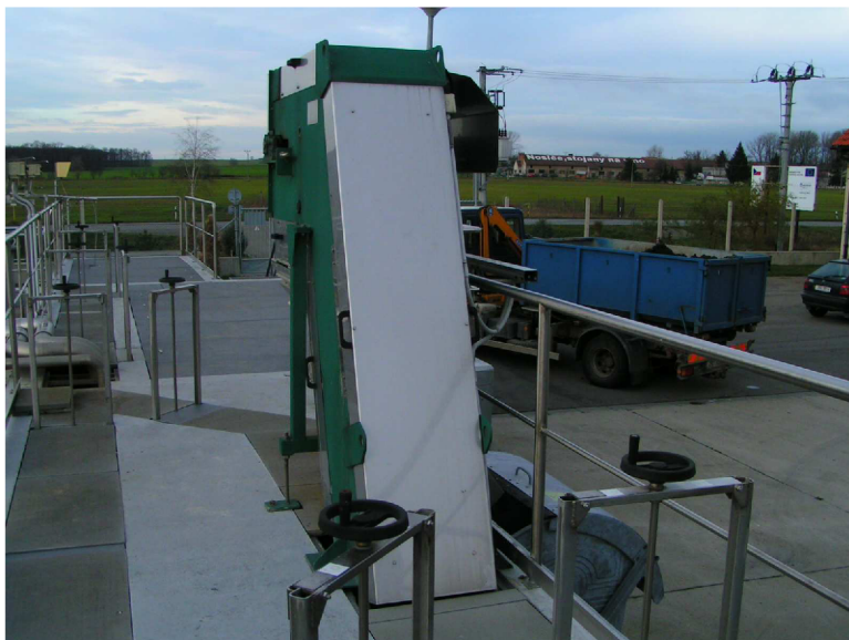
Obr. 2.2 Strojně stírané česle s kontejnerem na shrabky
