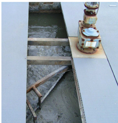
Obr. 2.6 Pohled na stírací zařízení lapáku písku
