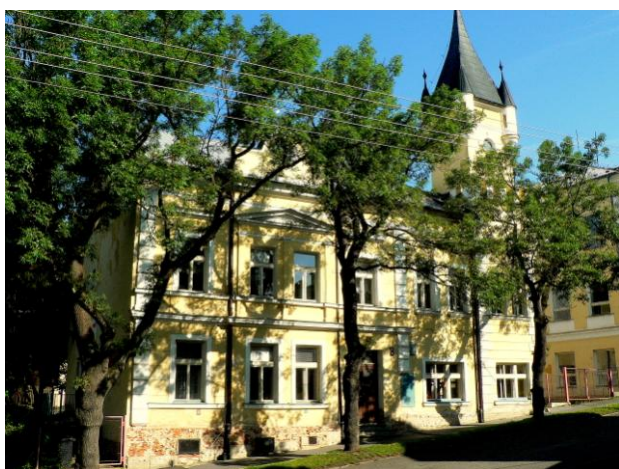
Budova školy v Úšovicích
