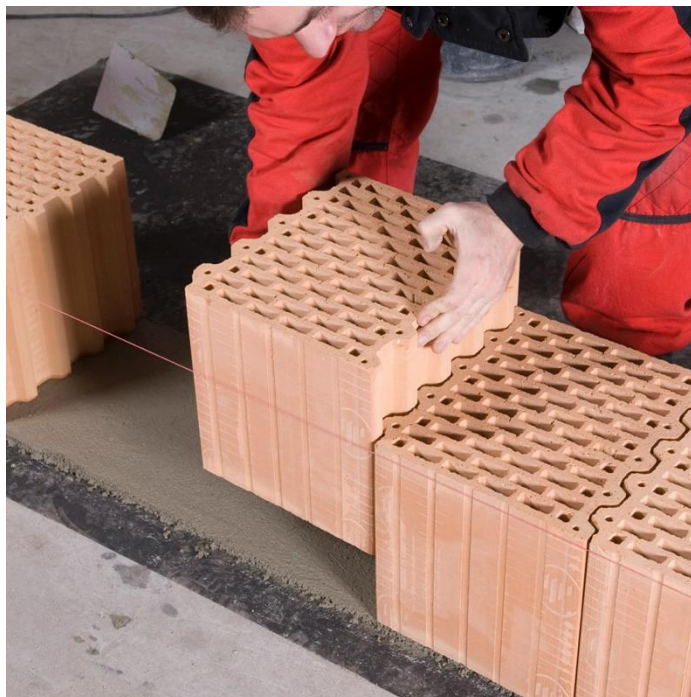
Obr. 42 Založení první vrstvy POROTHERM P+D
