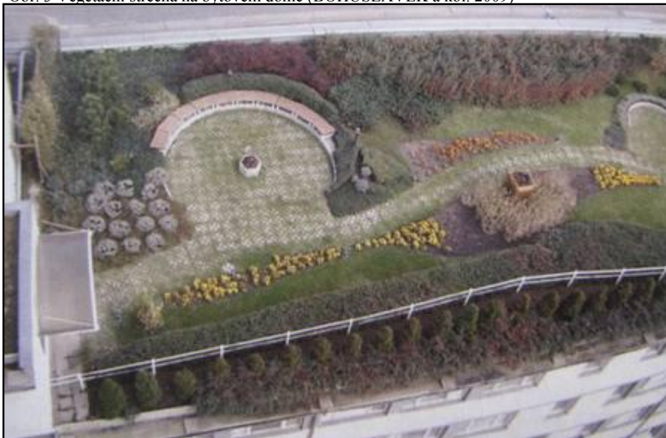
Obr. 3 Vegetační střecha na bytovém domě (BOHUSLÁVEK a kol. 2009)
