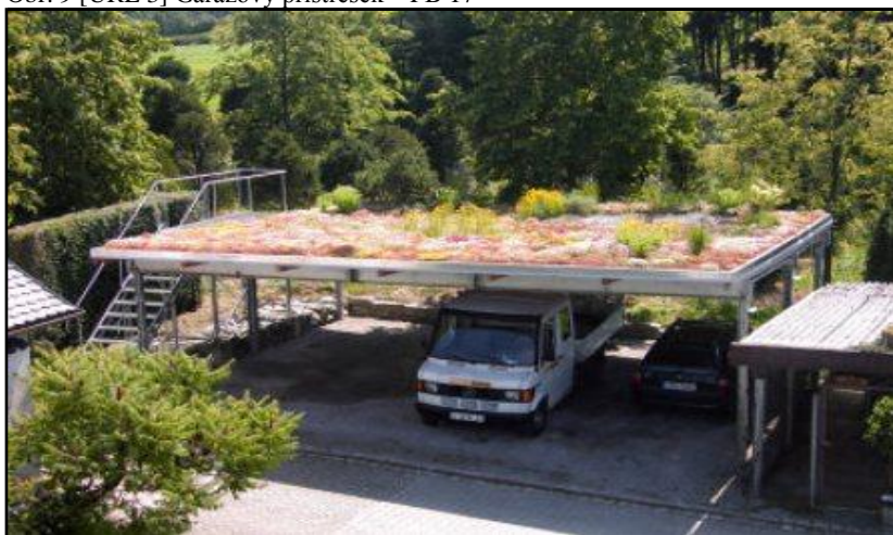
Obr. 9 [URL 3] Garážový přístřešek – PB 17
