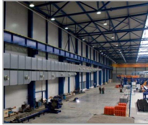
Obr. 16: Centrální větrání haly soustředěnými proudy [48]
