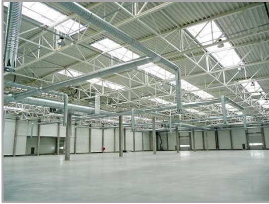
Obr. 15: Centrální větrání haly směšovací [47]
