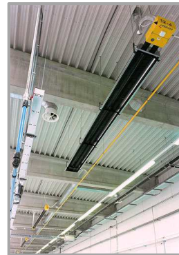
Obr. 22: Infračervený tmavý plynový zářič [54]
