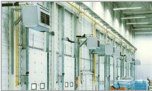
Obr. 21: Teplovzdušné vytápění nástěnnými jednotkami [53]
