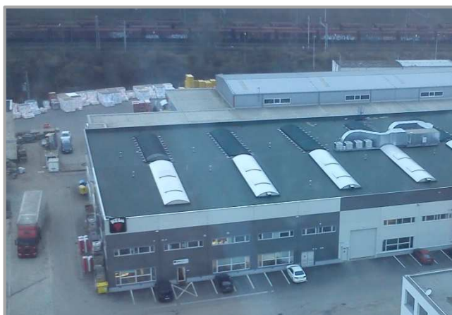
Obr. 62: Stínění světlíků provozu 1 na VP3 rašlovým úpletem.
