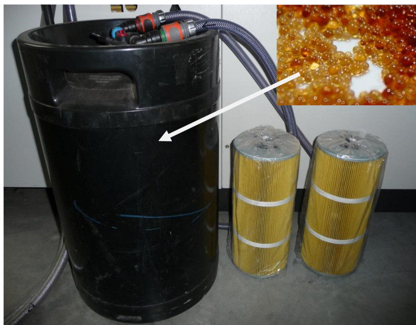
Obr. 3.12 Papirové filtry a deionizační láhev s kuličkami pryskyřice.
