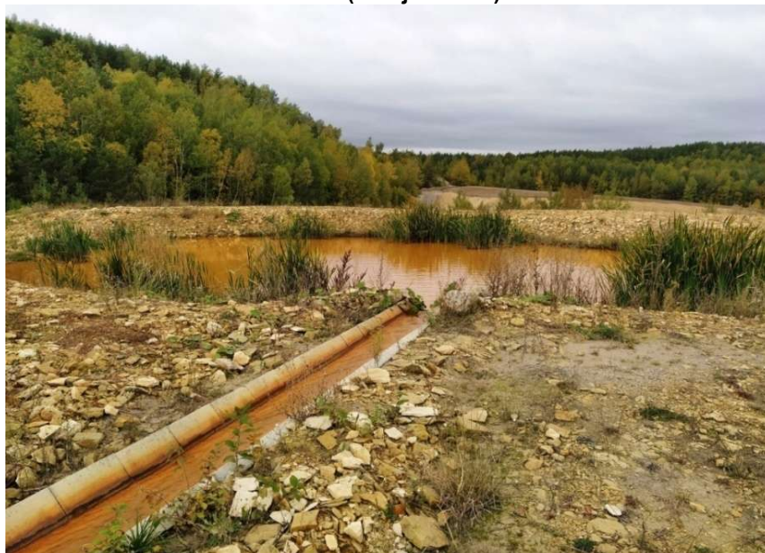
Obrázek 17: Vybudované koryto, které odvádí přebytečnou vodu do přírodní vodoteče (zdroj: vlastní)
