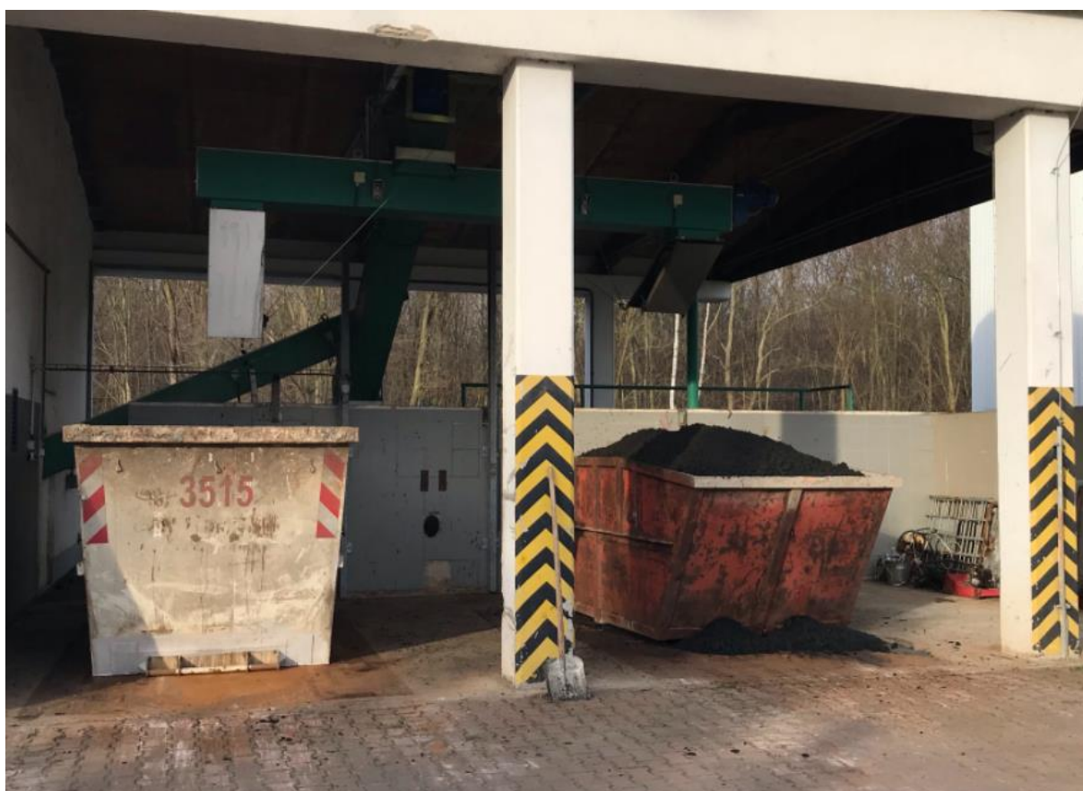
Obrázek 17 - Úložiště stabilizovaného kalu ČOV Kolín (autor)
