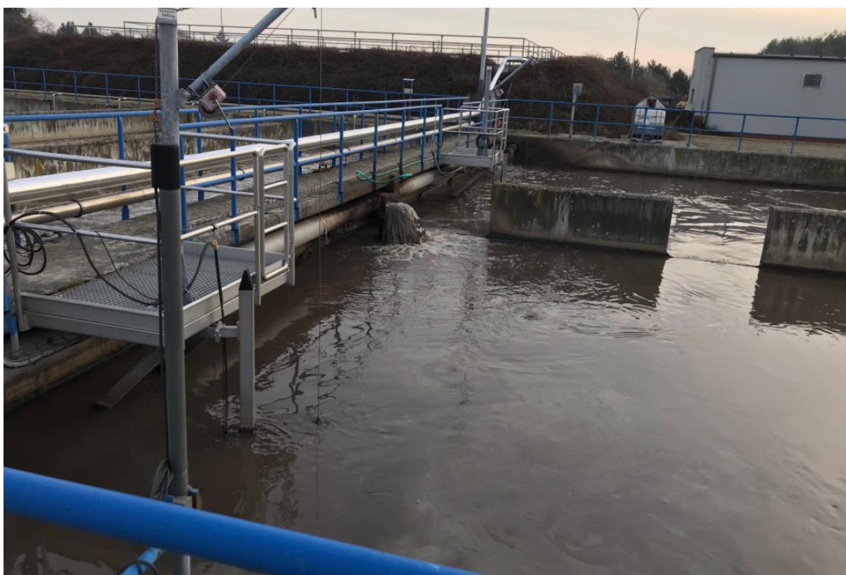
Obrázek 8 - Anaerobní nádrž ČOV Kolín (autor)
