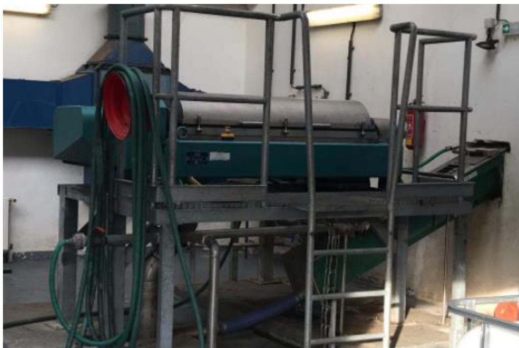
Obrázek 16 - Odstředivka ČOV Kolín (autor)
