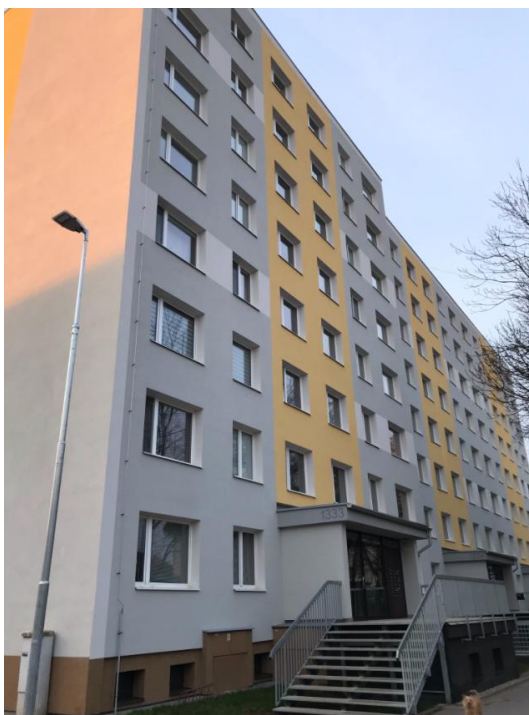
Obrázek 27 - Pohled na bytový dům (autor)
