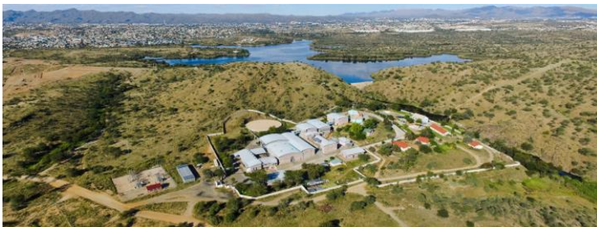
Obrázek 22 - Pohled na ČOV s recyklací vody na vodu pitnou v Namibii (20)
