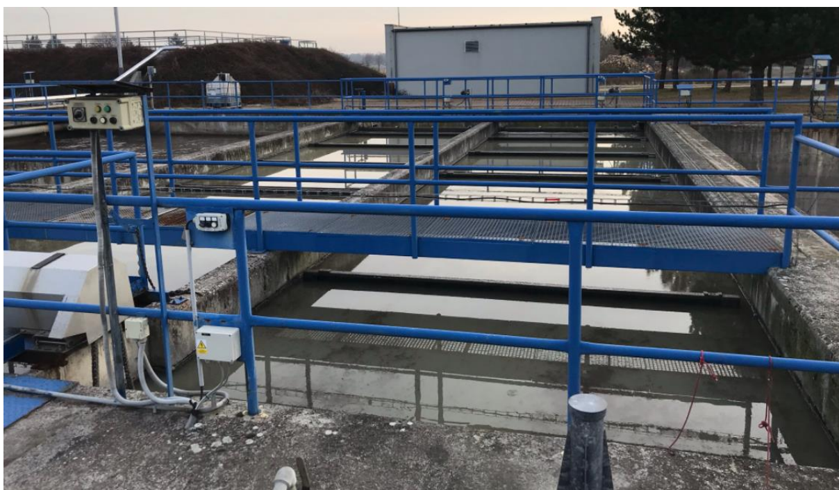
Obrázek 7 - Usazovací nádrže na ČOV Kolín (autor)
