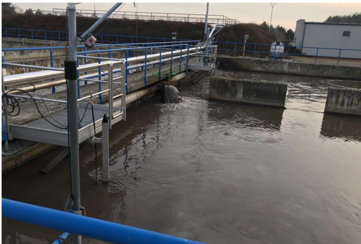
Obrázek 8 - Anaerobní nádrž ČOV Kolín (autor)
