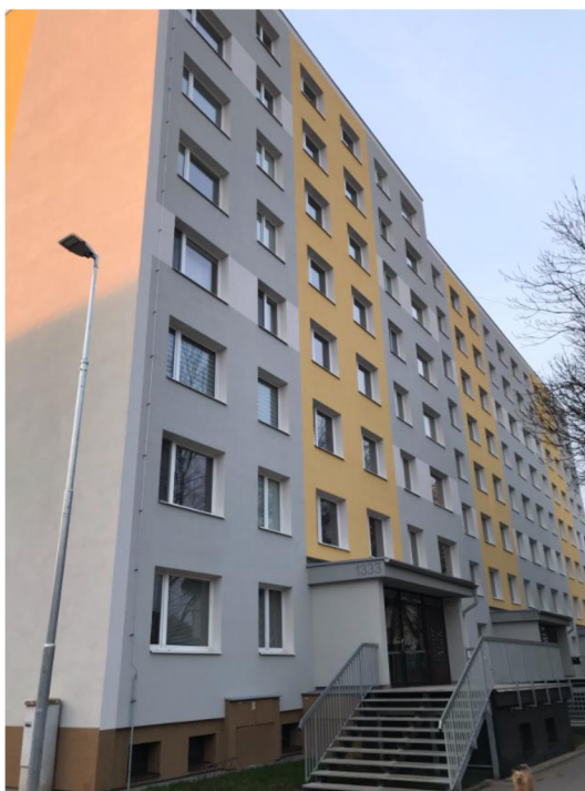
Obrázek 27 - Pohled na bytový dům (autor)
