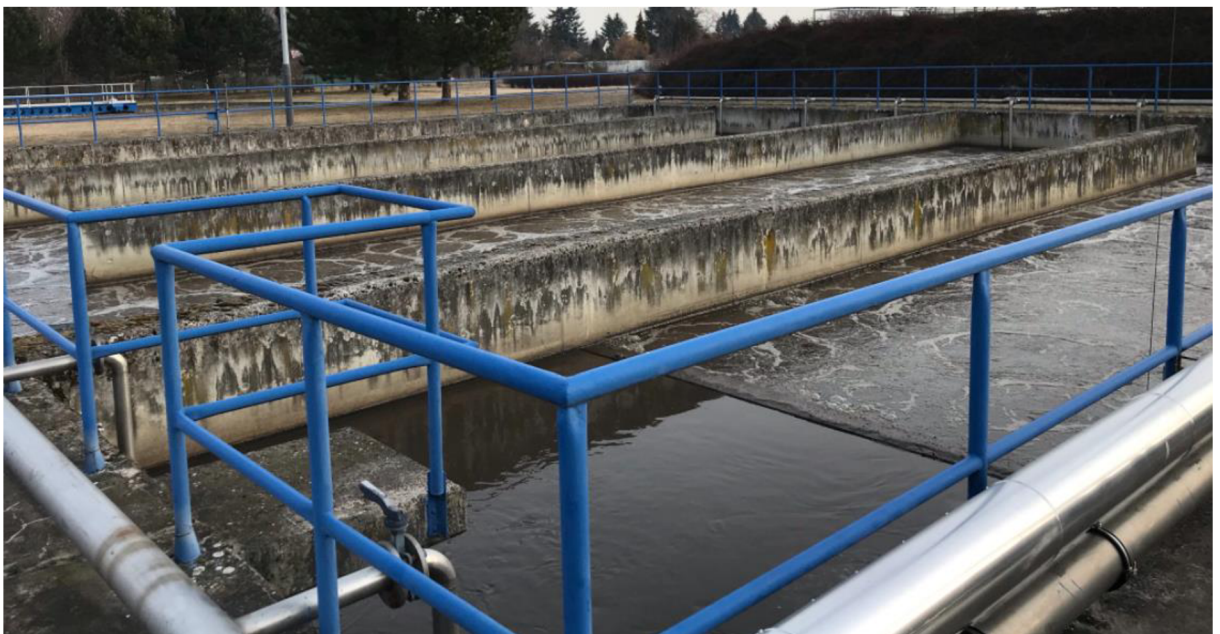
Obrázek 9 – Aktivace - denitrifikační a nitrifikační nádrže (autor)
