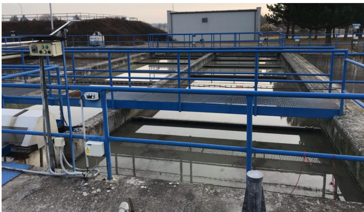
Obrázek 7 - Usazovací nádrže na ČOV Kolín (autor)
