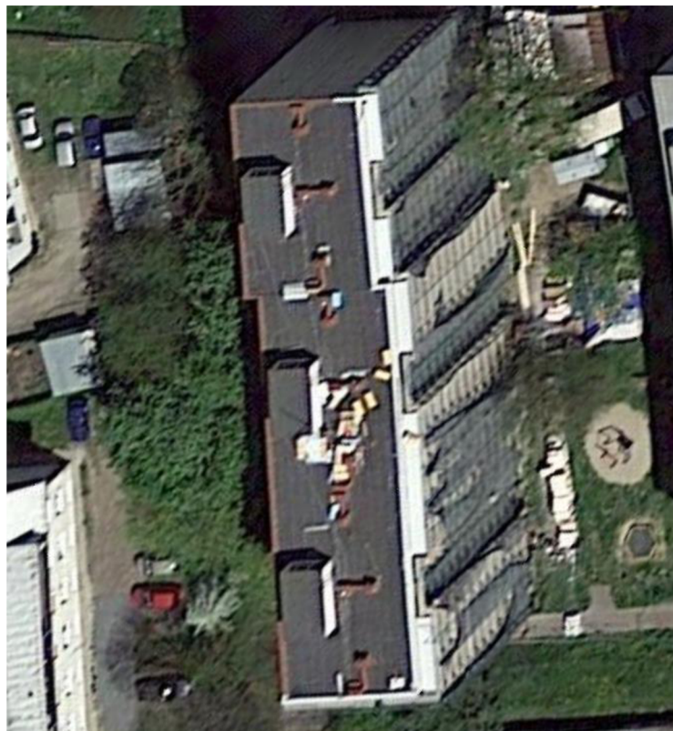
Obrázek 29 - Satelitní snímek střechy bytového domu (28)
