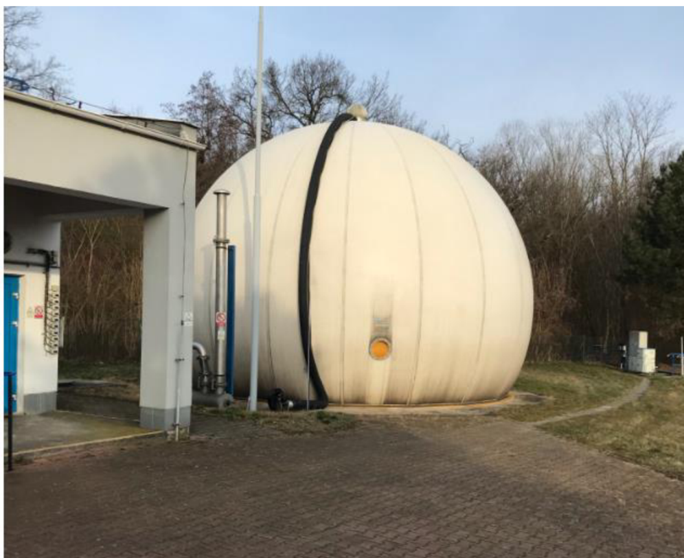
Obrázek 20 - Plynojem na ČOV v Kolíně (autor)
