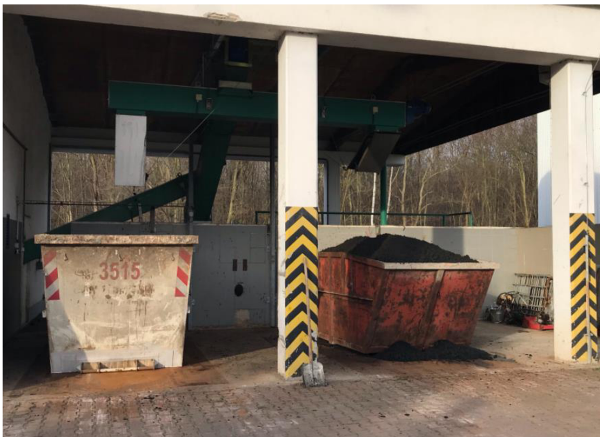
Obrázek 17 - Úložiště stabilizovaného kalu ČOV Kolín (autor)
