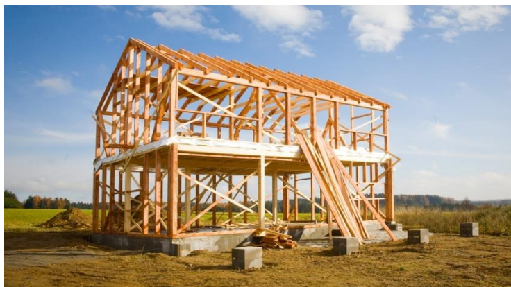
Obrázek 4: Rámová nosná konstrukce
