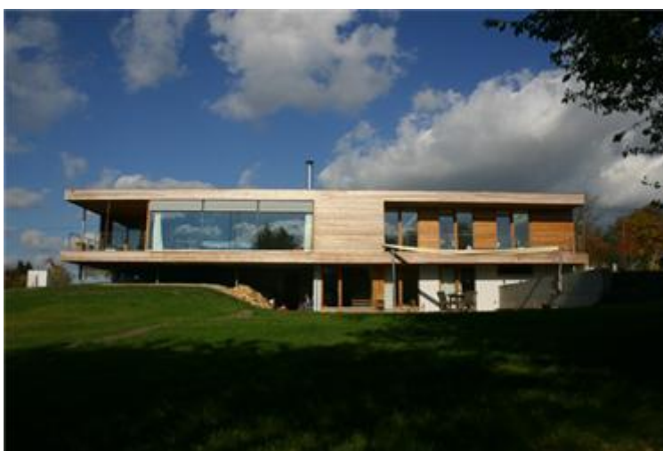
Obrázek 3: Energeticky úsporná panelová dřevostavba
