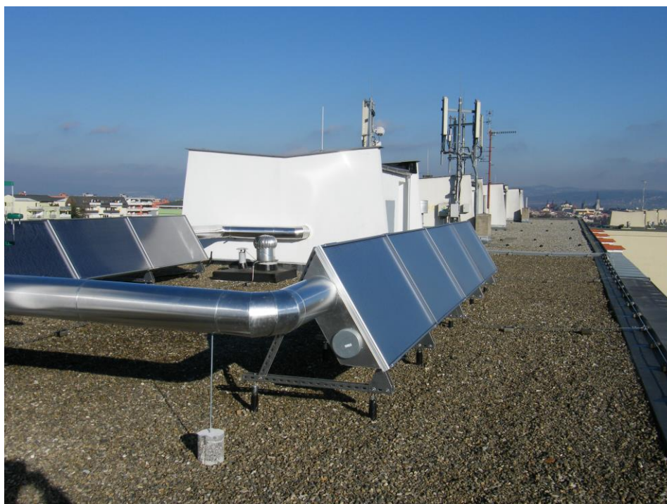
Obrázek 8 – Výsledná podoba střechy (Zdroj: vlastní)
