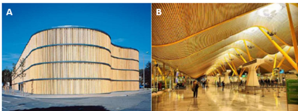
Obrázek 23 A) Garáž s bambusovou fasádou v Lipsku B) Bambusový strop na Mezinárodním letišti v Madridu [60]
