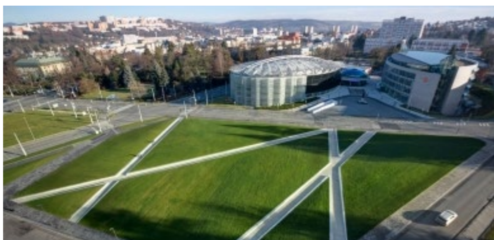
Obr. č. 91, Revitalizace Gahurova prospektu, Zlín (archiweb.cz)
