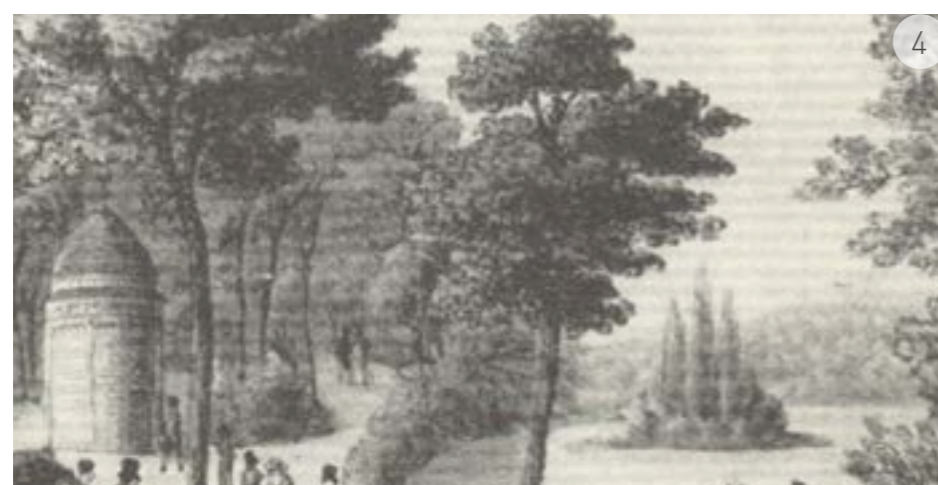
Obr. č. 153, Paviilon a malé jezírko v Zámecké zahradě r. 1829
