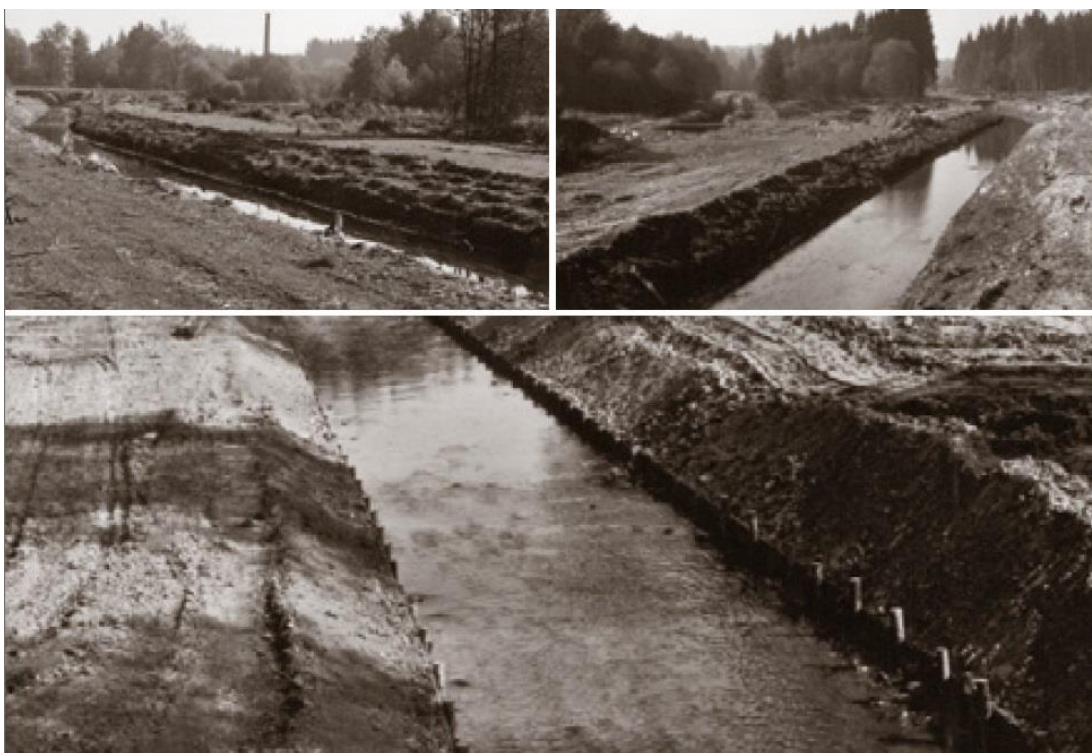
Obr. 27. Koryto Kateřinského po dokončení úpravy 1968 -1972, na dolním obrázku viditelné opevnění břehů laťovými plůtky Zdroj: ex Kůs 2012
