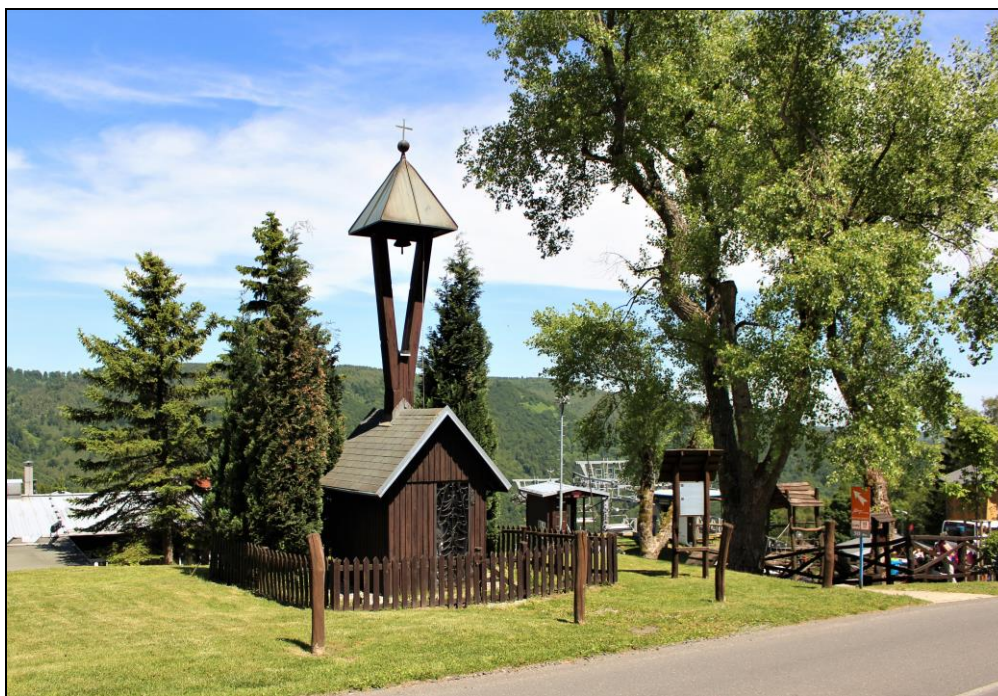
Obrázek 32 - Dřevěná zvonička v obci Klíny
