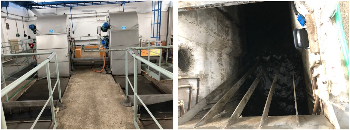
Obrázek 8 - Místo odběru vzorku B směsi čtyř přítoků odpadní vody do ČOV - prostory ČOV s umístěním hrubých česlí
