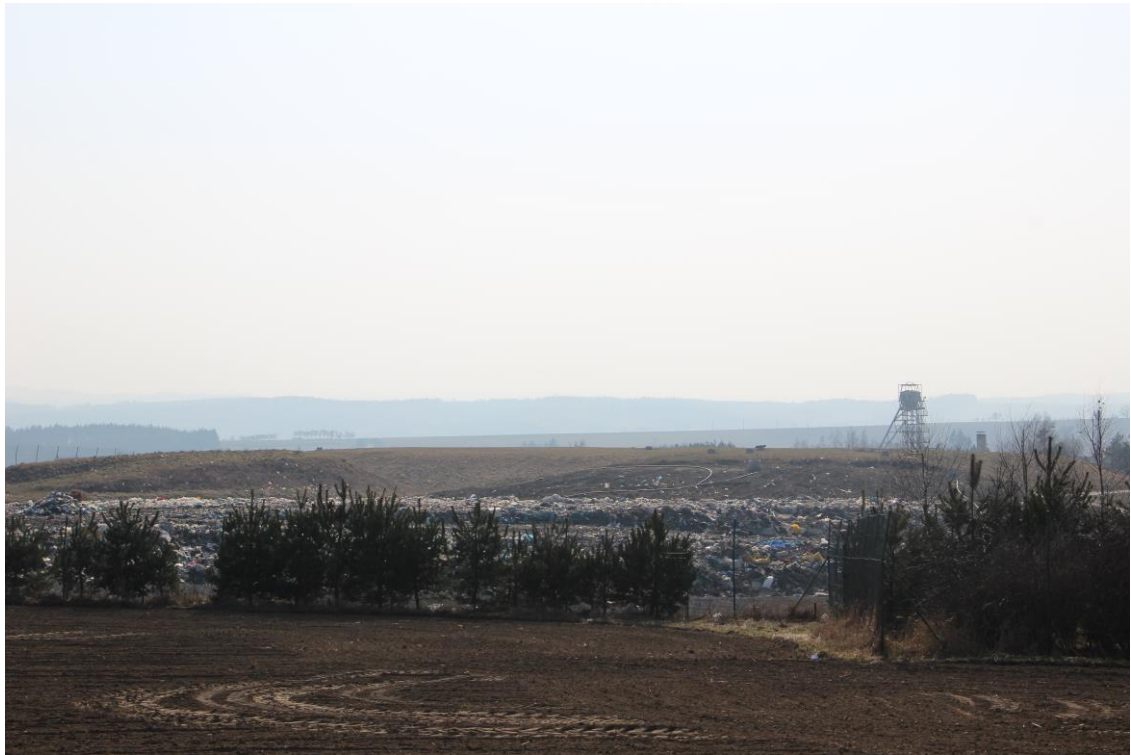
Obrázek 7 Řízená skládka TKO Bukov (Zdroj: vlastní fotografie, 2015)
