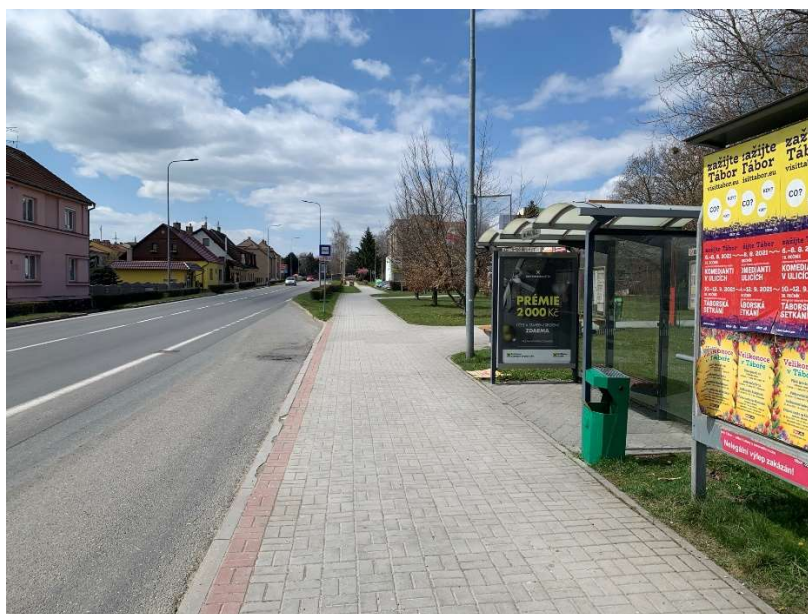
Obrázek 33 - Chybné provedení zastávky "Nemocnice" ve směru do Klokot
