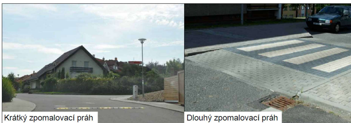
Obrázek 10 - Rozdíl mezi krátkým a dlouhým zpomalovacím prahem
