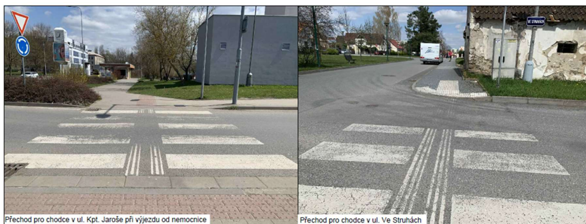
Obrázek 29 - Ukázka špatného stavu VDZ V7a - Přejchod pro chodce
