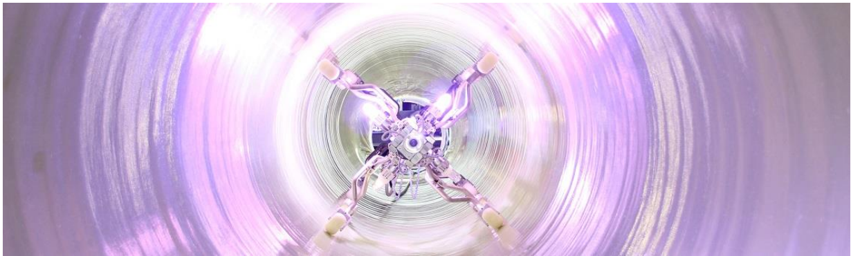
Obr. 7 Vytvrzování pomocí UV záření, metoda CIPP [40]
