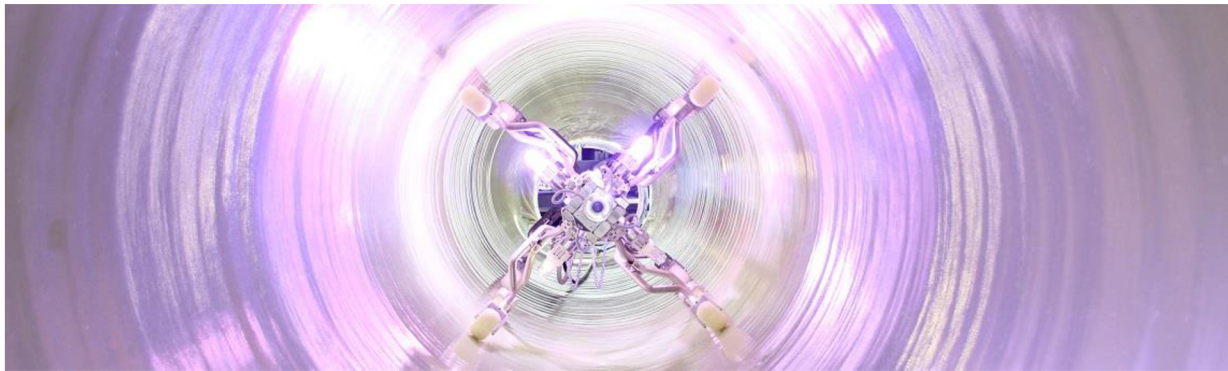
Obr. 7 Vytvrzování pomocí UV záření, metoda CIPP [40]
