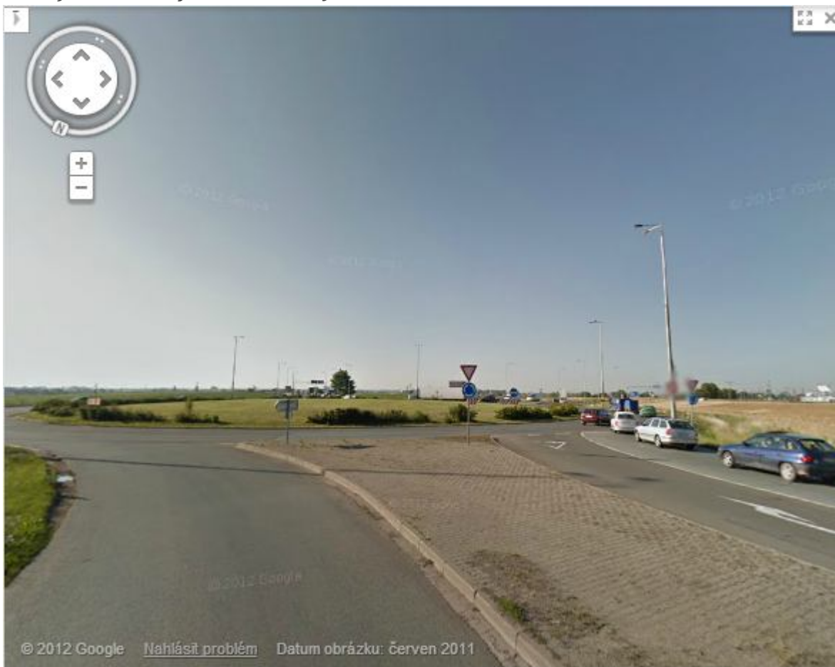
Obr. 10) Pohled na vjezdu do OK od Jičína
