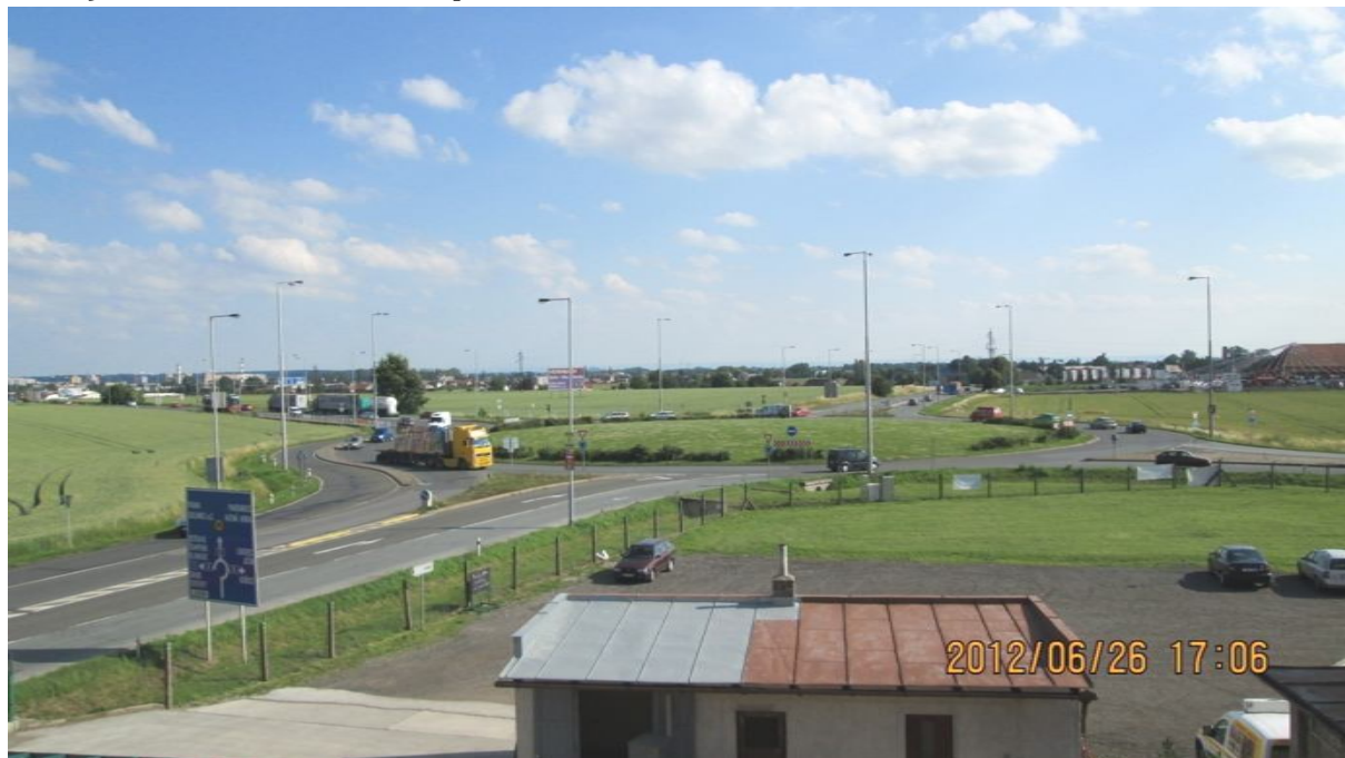
Obr. 1) Pohled na křižovatku z pozorovacího staniště
