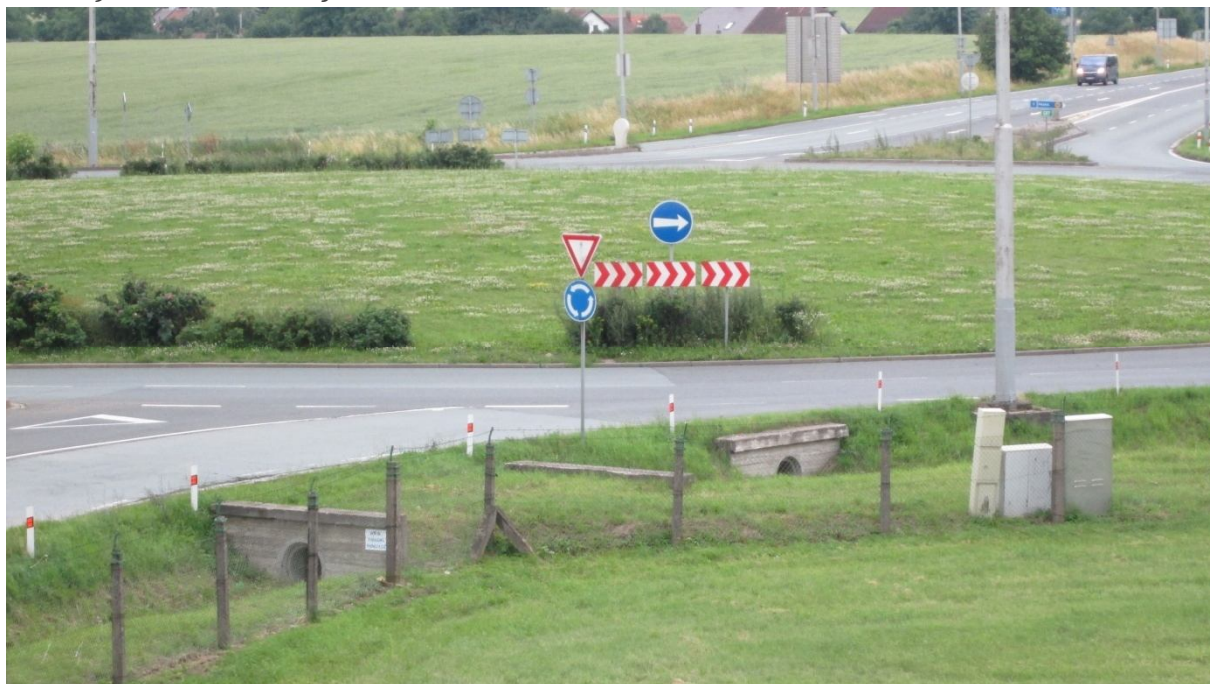
Obr. 13) Pohled na stávající odvodnění
