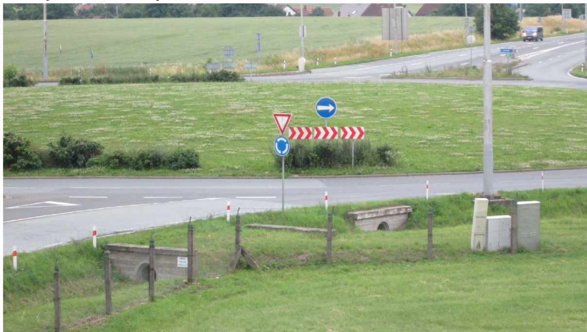
Obr. 13) Pohled na stávající odvodnění
