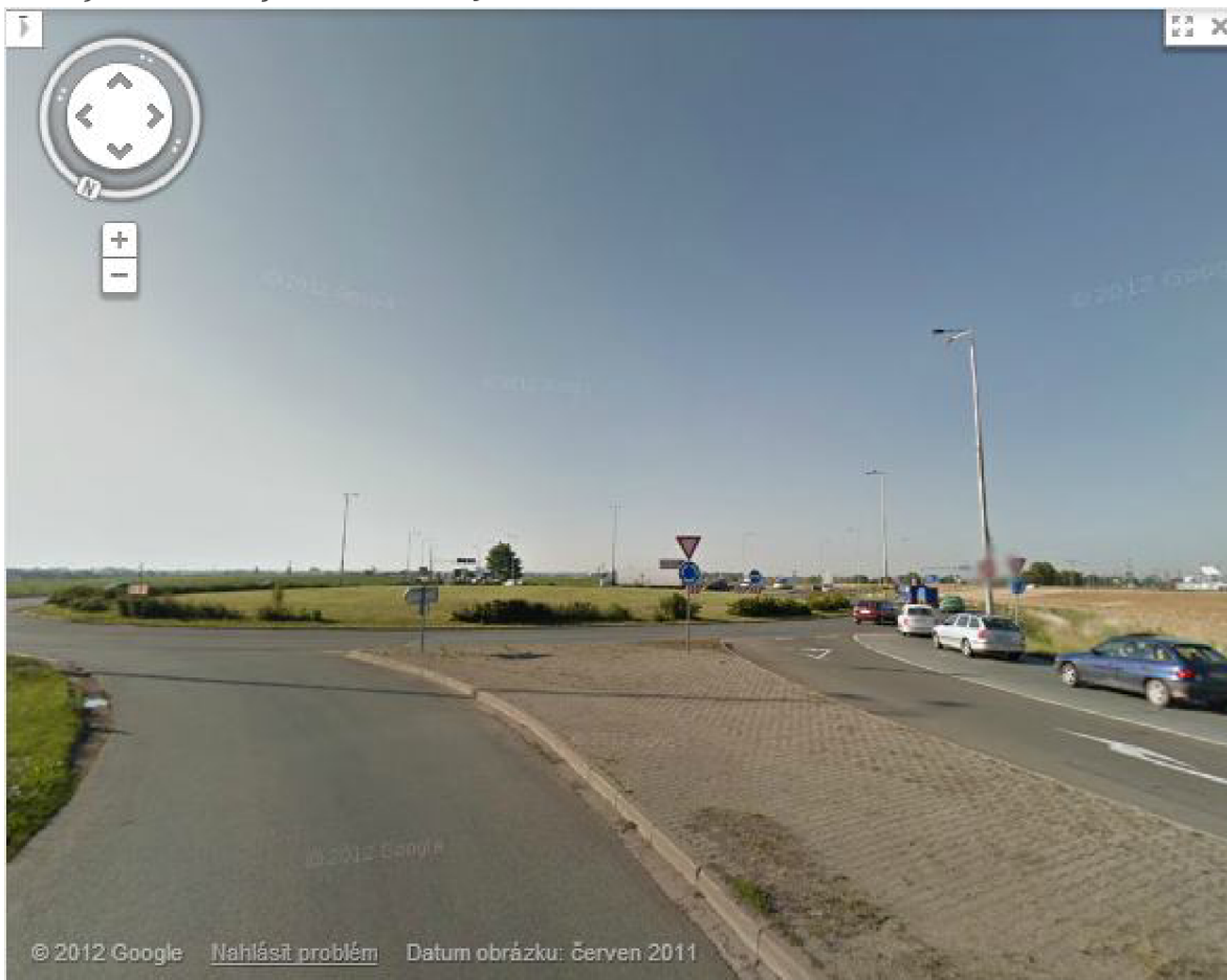
Obr. 10) Pohled na vjezdu do OK od Jičína
