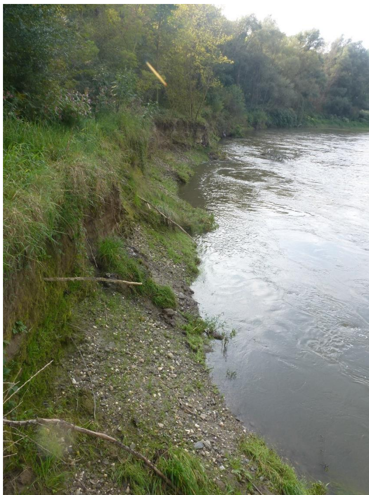
Foto č. 7: Břehová nátrž (Skokanová, M. 9/2014)
