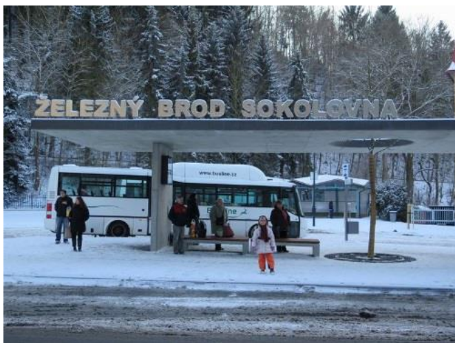
Obrázek 5: Terminál v Železném Brodě
