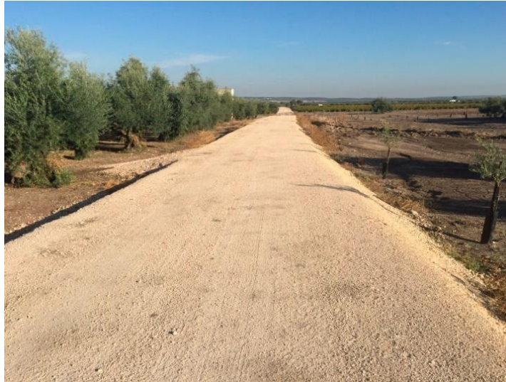
Obrázek 2.14 - Hotová nezpevněná silnice [33]
