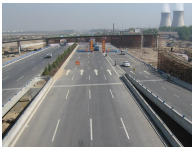
Obrázek 2.13 - Hotová silnice Sanhuan road in Xi'an [29]
