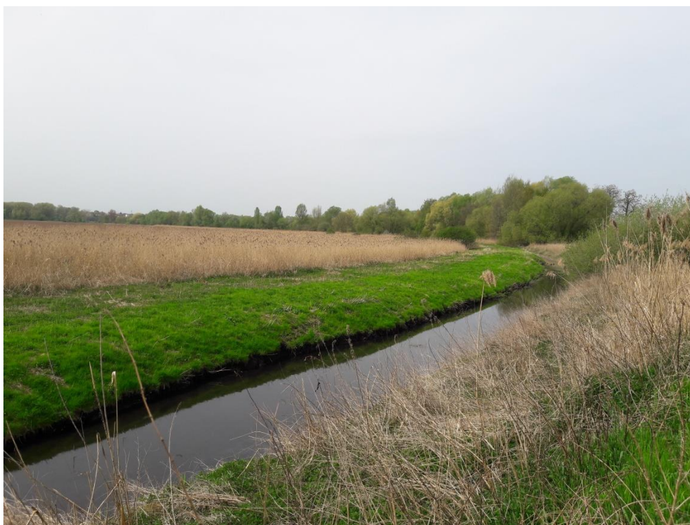
Obr. č. 20: Odvodňovací příkop (zdroj: fotoarchiv autorky, 2018)
