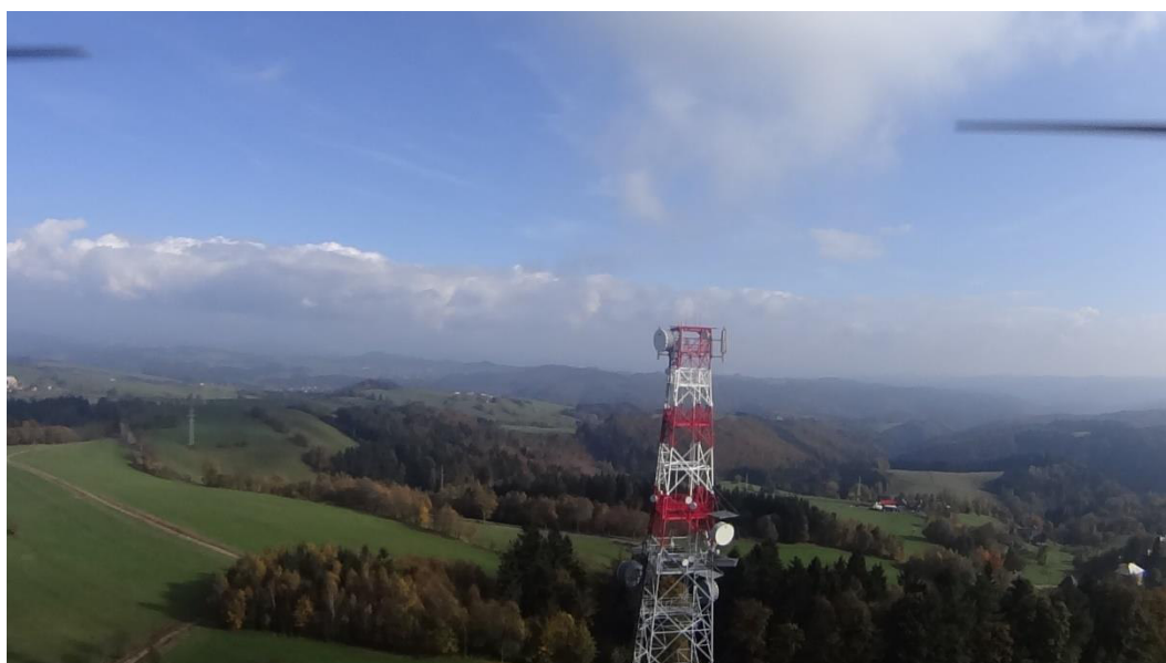
obr. 13: Pohled na východ ve výšce 30 m
