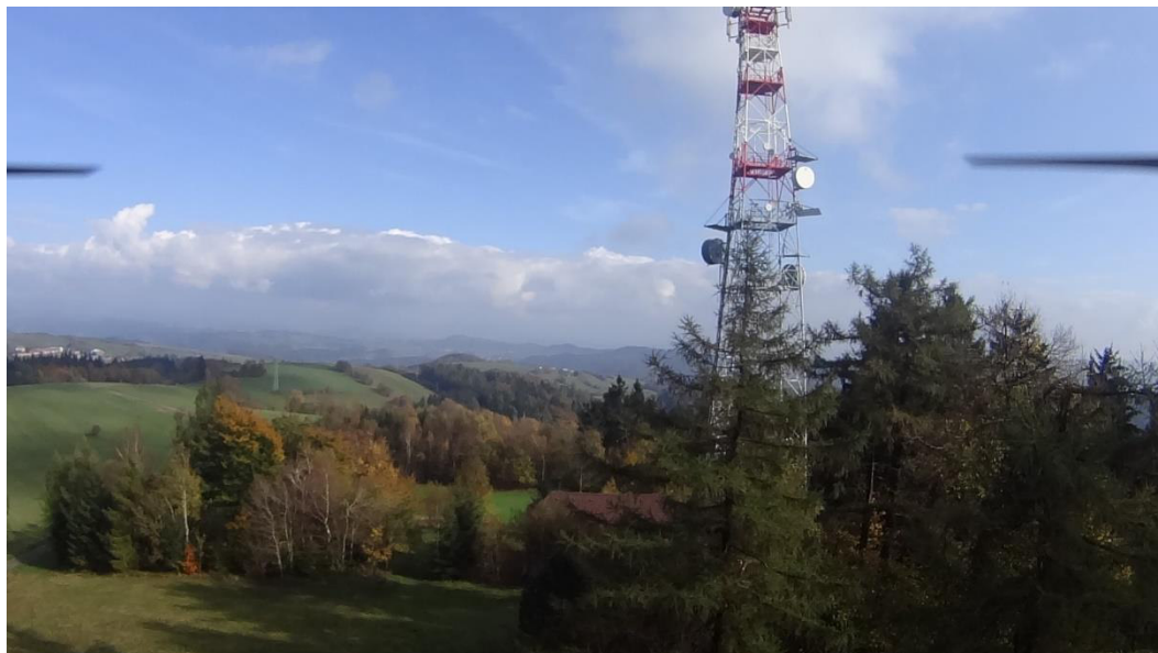
obr. 12: Pohled na východ ve výšce 20 m
