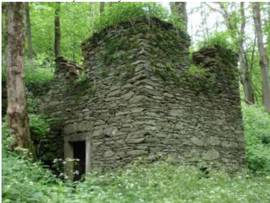
Foto č.2: Torzo mlýnu v zaniklých Sklenářovicích
