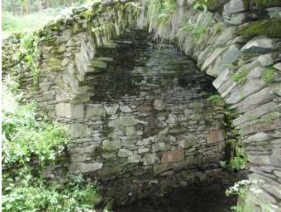
Foto č.1: Torzo mostu v zaniklých Sklenářovicích
