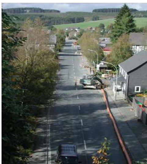
Obr. č. 20: Příprava potrubí pro zatažení technologií Long Pipe Burstlining; Endtebrück, Německo, denně zde bylo zrekonstruováno cca 200 metrů řadu (Tracto - Technik)
