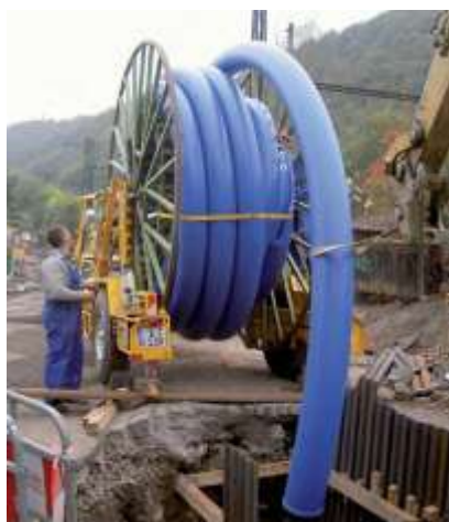
Obr. č. 17: Navinutá PE vložka připravená k zatažení (Zeppris)
