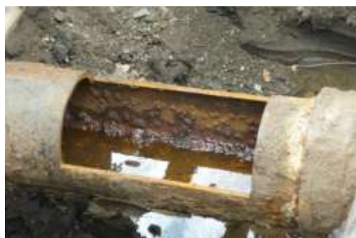
Obr.č. 6 a,b: Čištění potrubí – a) čistící vybavení, b) výřez na potrubí (© Maiová,2011)
