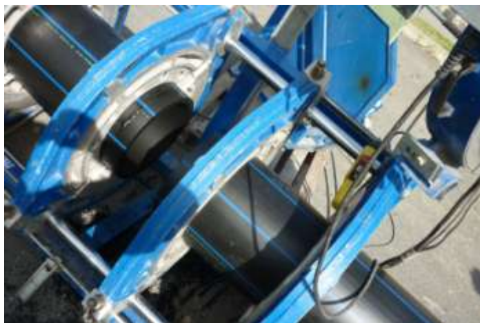
Obr.č.5: Svařování PE potrubí metodou na tupo (© Maiová,2011)
