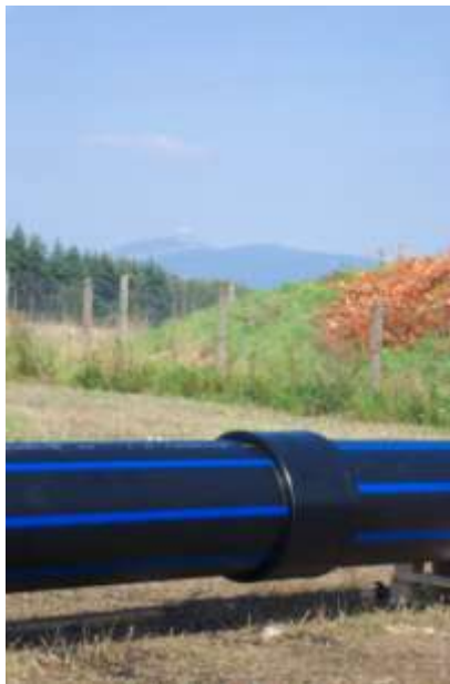
Obr.č.6: Svařování PE potrubí pomocí elektotvarovky(© Maiová,2009)
