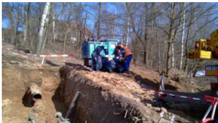
Obr.č. 7: Příprava zatahovacího stroje Grundoburst 2500 (© Maiová,2011)
