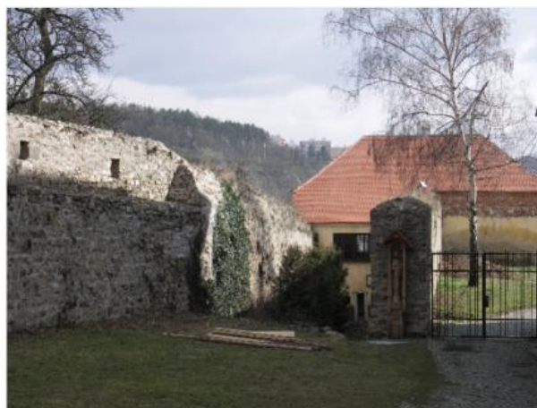
Obr. 17. Výzkum přístupové komunikace 2008, pohled na místo sond č. 3 a 5. Přístupová komunikace a koridor (Zdroj: Vokáč 2008).
