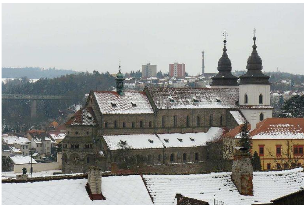
Obr. 81. Pohled na areál bývalého kláštera ze severu (Zdroj: Macoszková 2013).
