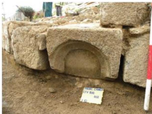
Obr. 38. Rekonstrukce kvadratury a vnějšího nádvoří 2011 – 2012, III. etapa - exteriér, jižní část vnějšího nádvoří. Druhotně použitý románský prvek v základu novověké zdi (Zdroj: Vokáč 2013).
