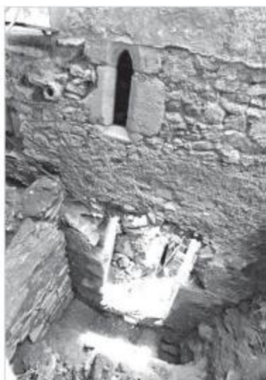
Obr. 21. Budova v jižní ohradní zdi. Zachovaný portál z 1. stavební fáze, okno z 2. stavební fáze a v popředí je předsíň z 3. stavební fáze (Zdroj: Kolařík - Merta – Peška 2011, 157).
