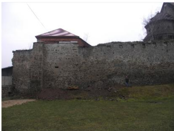
Obr. 16. Výzkum přístupové komunikace 2008, pohled na místo sond č. 1, 2 a 2. Severní zeď přístupové komunikace, pozdní středověk. (Zdroj: Vokáč 2008).
