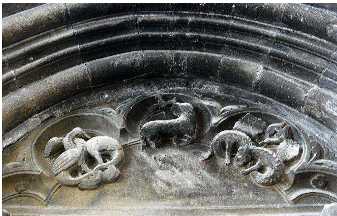
Obr. 97. Tympanon portálu do bývalé kvadratury (Zdroj: Macoszková 2013).
