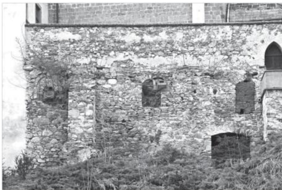
Obr. 20. Zachované obrysy oken z 2. stavební fáze zaniklé budovy v jižní ohradní zdi klášterního areálu (Zdroj: Kolařík – Merta – Peška 2011, 154).
