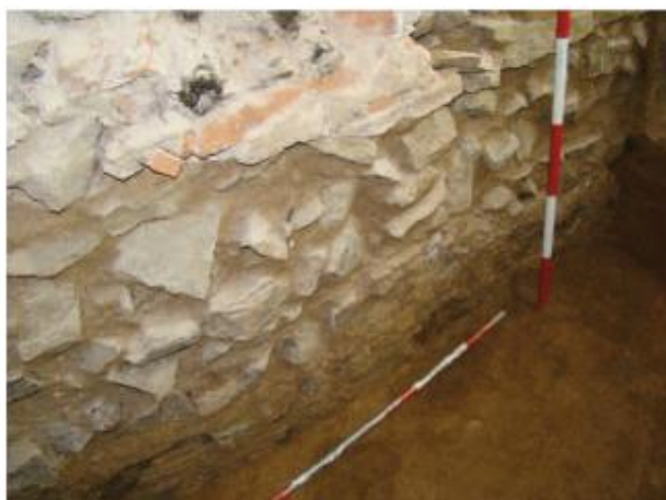
Obr. 33. Rekonstrukce kvadratury a vnějšího nádvoří 2011 – 2012, I. etapa - interiér, I. podlaží. NM XIII. Základ zdi ambitu z poloviny 13. století (Zdroj: Vokáč 2013).
