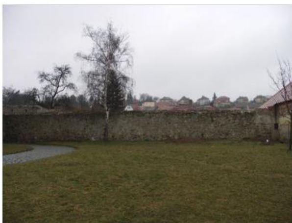
Obr. 18. Výzkum přístupové komunikace 2008, pohled na místo sond č. 4 a 6. Jižní zeď přístupové komunikace, původní hradba kláštera (Zdroj: Vokáč 2008).
