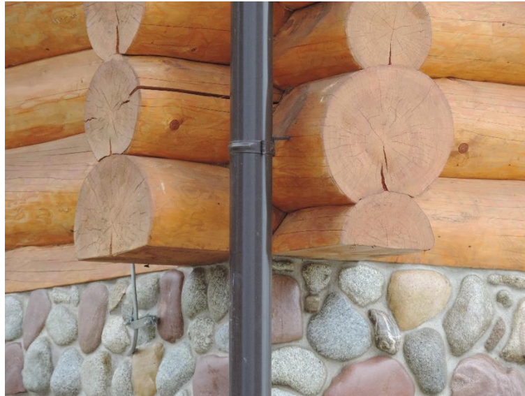
Obr. 1. – Uložení prahové klády
