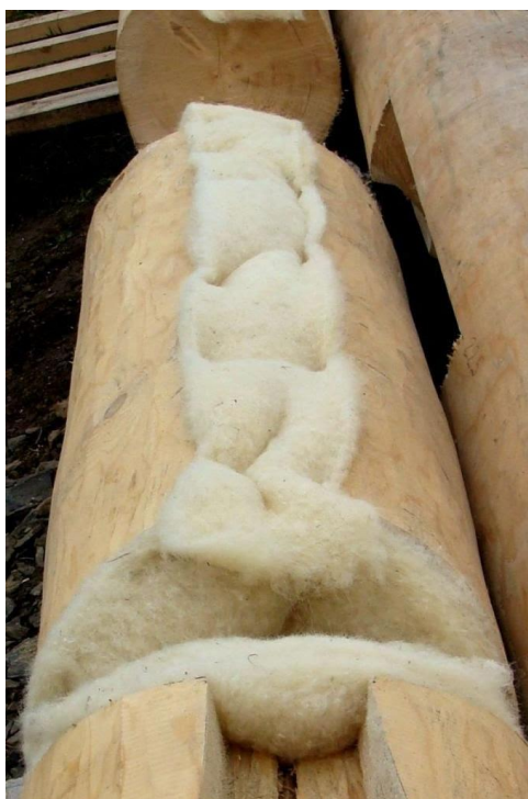
Obr. 5. – Podélná drážka vyplněná ovčí vlnou a opatřená paměťovou páskou
