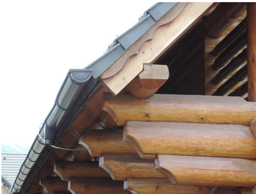
Obr. 7. – Uložení podpůrné kulatiny na přesahy pro osazení krokvi
