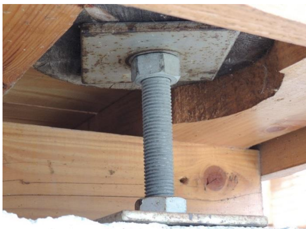
Obr. 11. – Příklad aretačního nastavitelného šroubu
