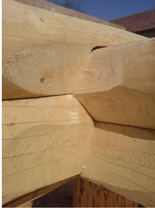
Obr. 2. – Samosvorný sedlový spoj (www.srubyzikr.cz)
