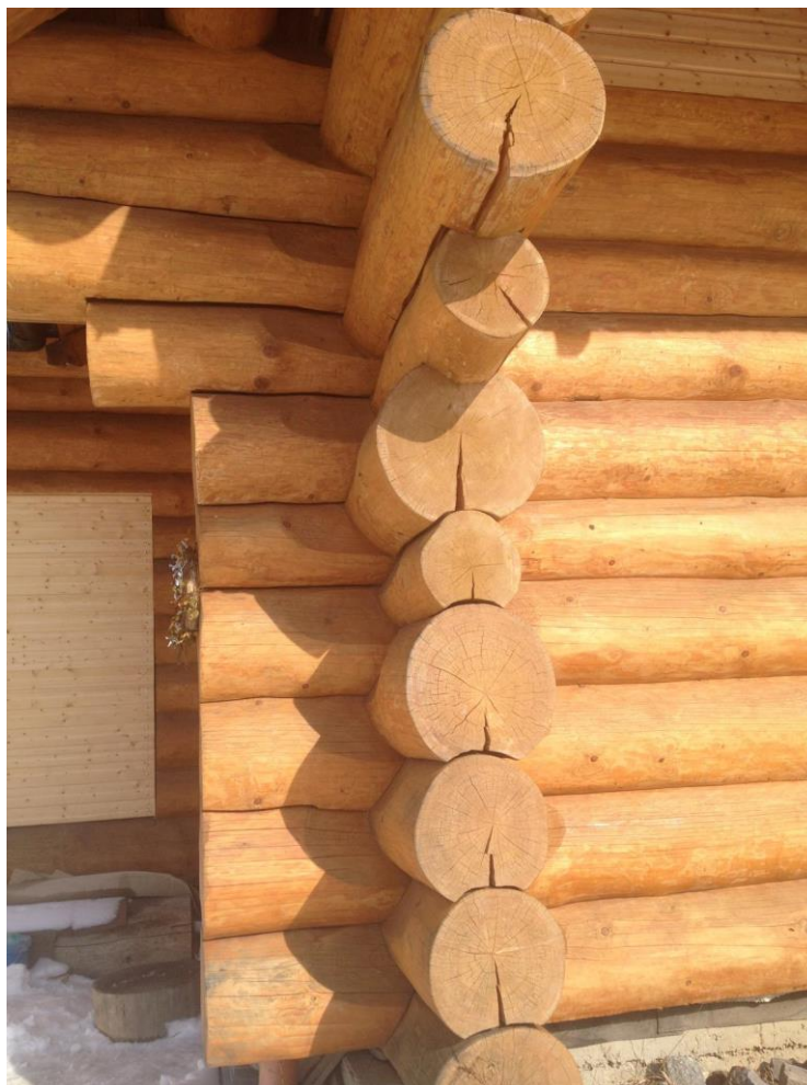
Obr. 6. – Porušení kulatin vlivem absence uvolňovacích zářežů
