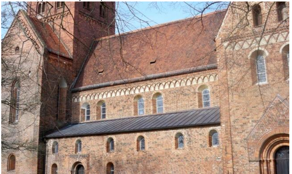
10. Diesdorf, Sasko-Anhaltsko, kostel Panny Marie, přelom 12. a 13. století, pohled od jihovýchodu.
