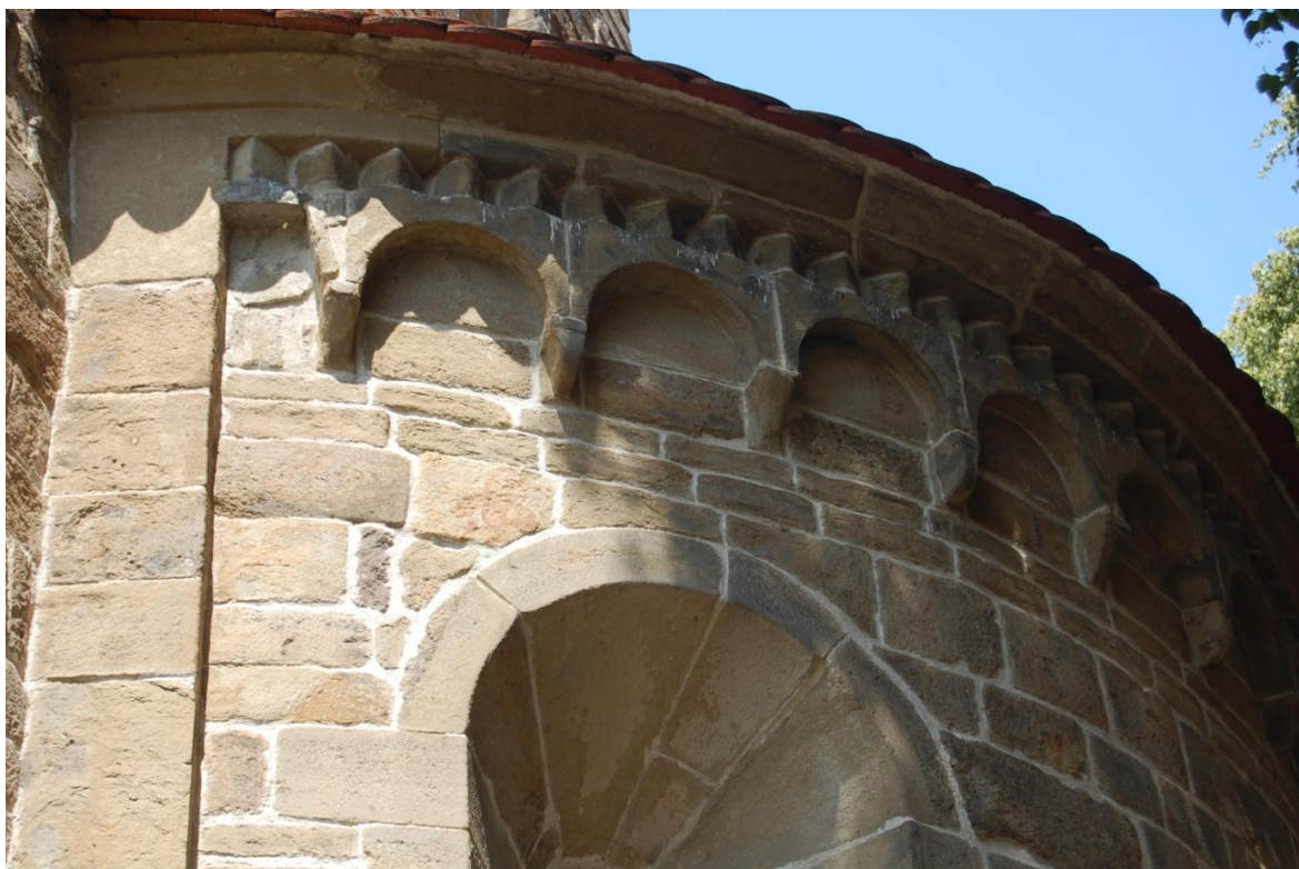
84. Řeznovice, kostel sv. Petra a Pavla, druhá polovina 12. století, podřímsí na východní apsidě od jihu.
