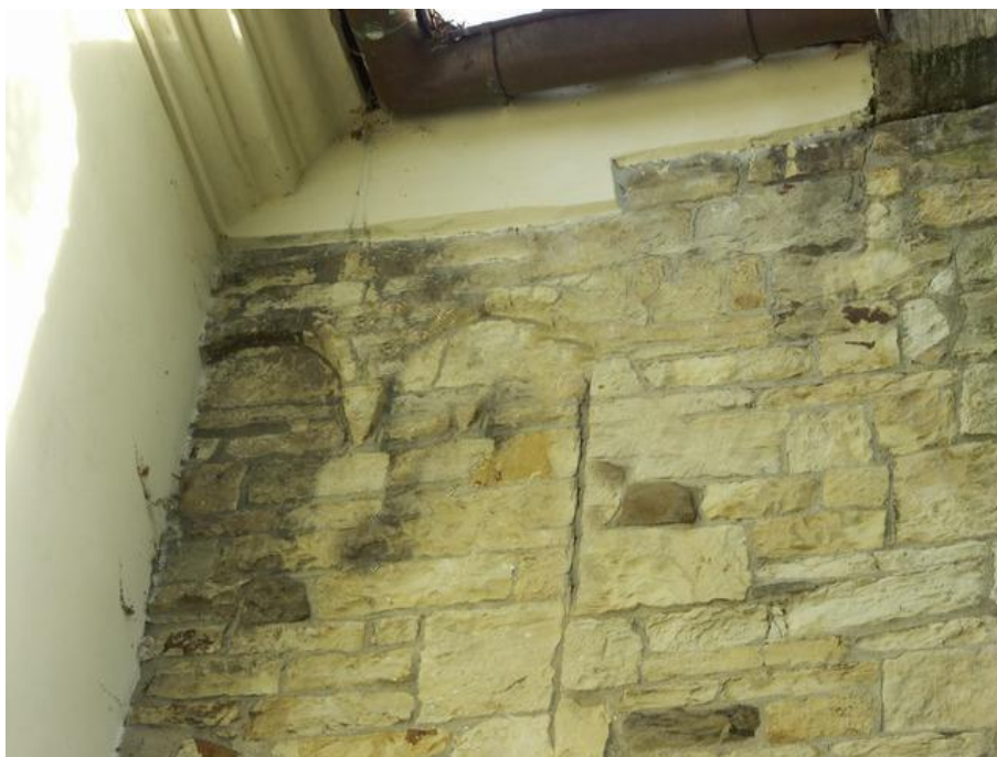
70. Zbraslav, kostel sv. Havla, druhá čtvrtina 12. století, fragment obloučkového vlysu na východní části severní fasády.
