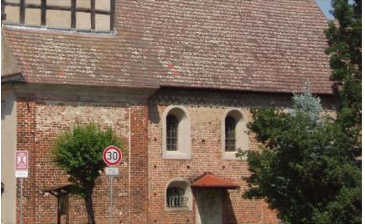
9. Wust, Sasko-Anhaltsko, kostel reformované církve, přelom 12. a 13. století, pohled od jihozápadu.
