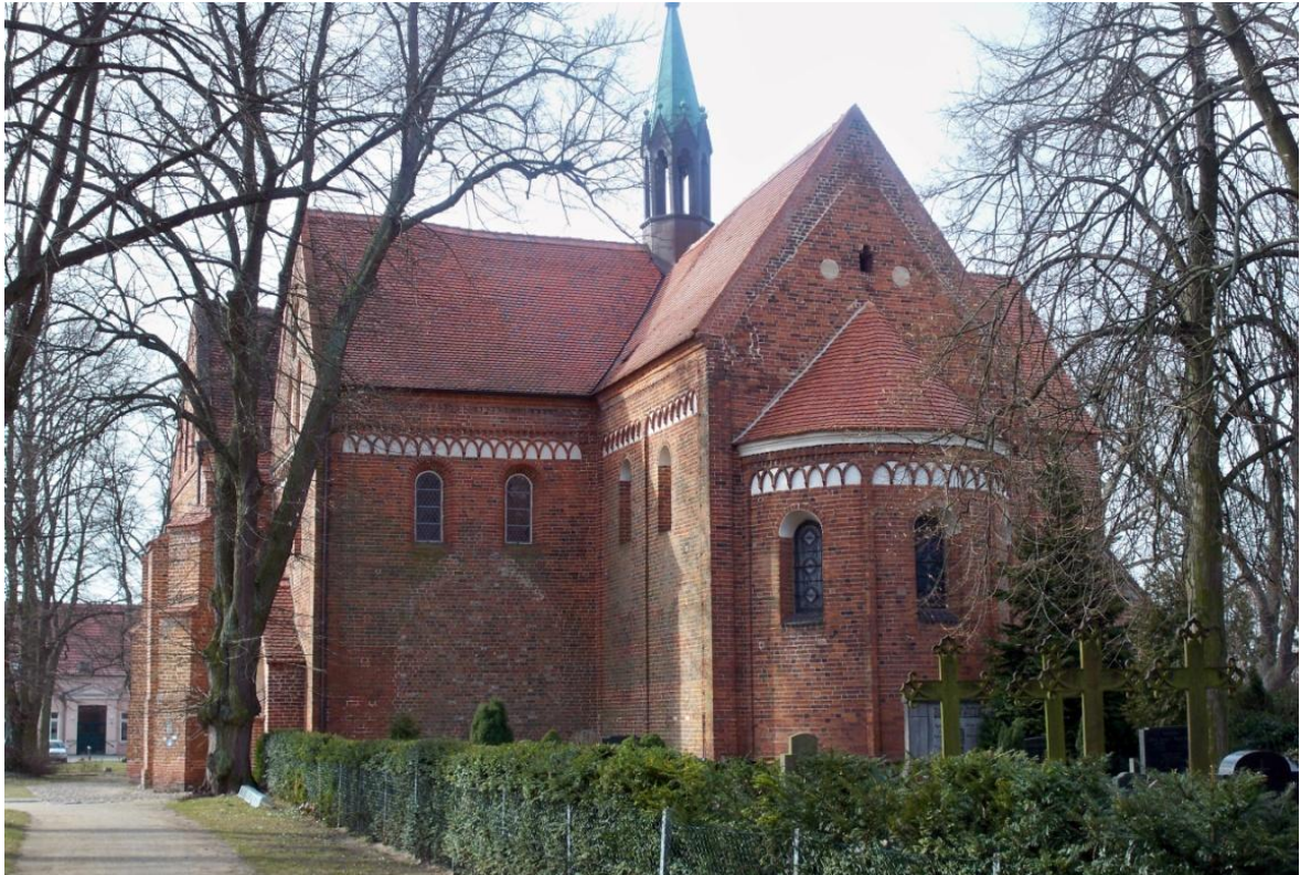
6. Arendsee, Sasko-Anhaltsko, klášterní kostel Panny Marie, Jana Evangelisty a sv. Mikuláše, konec 12. století, pohled od východu.
