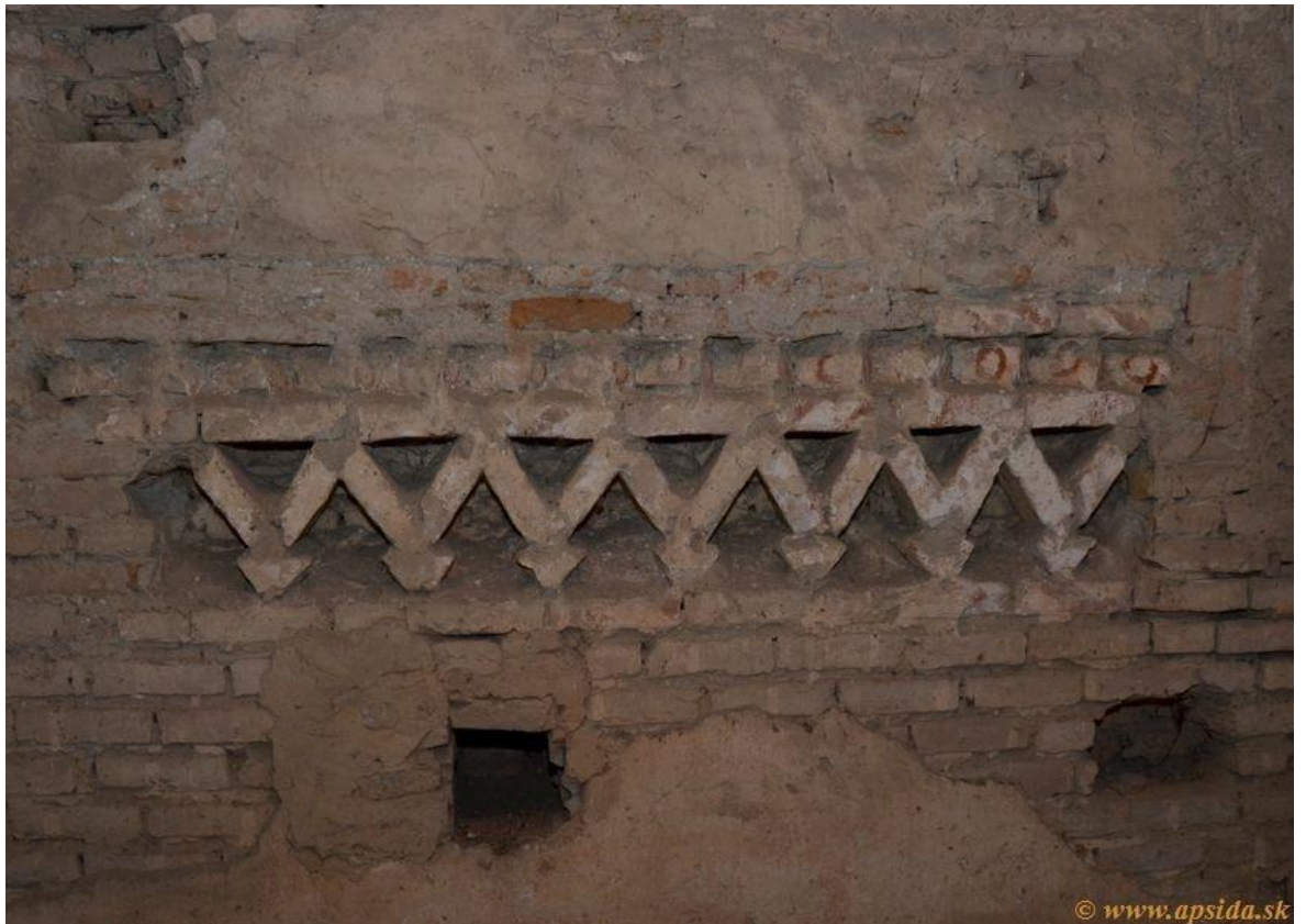
110. Šamorín, Slovensko, kostel reformované cirkve, prví polovina 13. století, severní fasáda.
