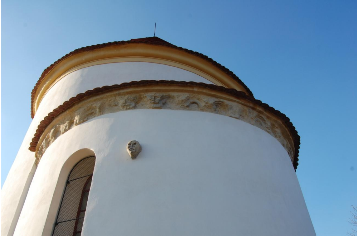
82. Želkovice, kostel sv. Petra a Pavla, první polovina 13. století, východní apsida.
