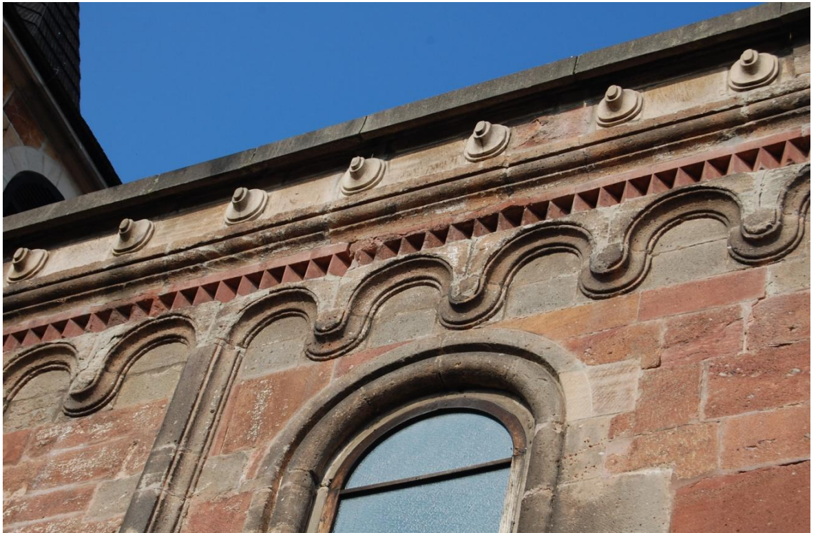
81. Vroutek, kostel sv. Jakuba Většího, první polovina 13. století, jižní podřímsí.
