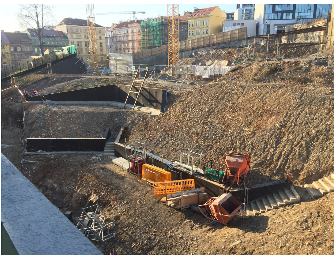
Obr. 14: Probíhající terénní úpravy pro následné sadové úpravy – kompenzační zeleň (vlastní fotografie)
