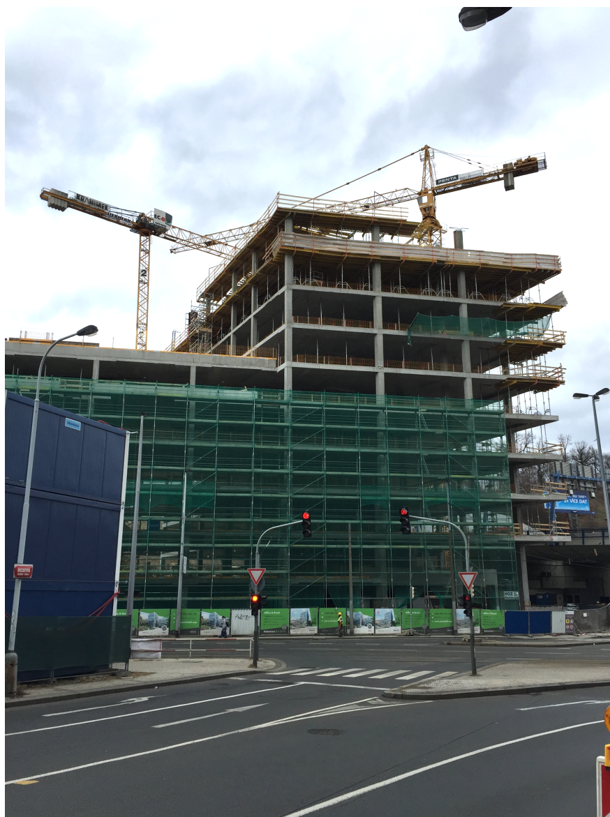
Obr. 11: Výškové členění budovy (vlastní foto)
