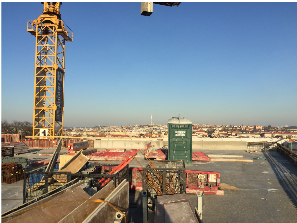
Obr. 15: Probíhající příprava pro umístění technologií – tepelná čerpadla vzduch-voda (vlastní fotografie)
