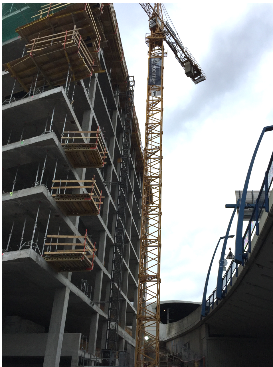
Obr. 12: Posuzovaný záměr se nachází v těsné blízkosti Strahovského tunelu (vlastní foto)
