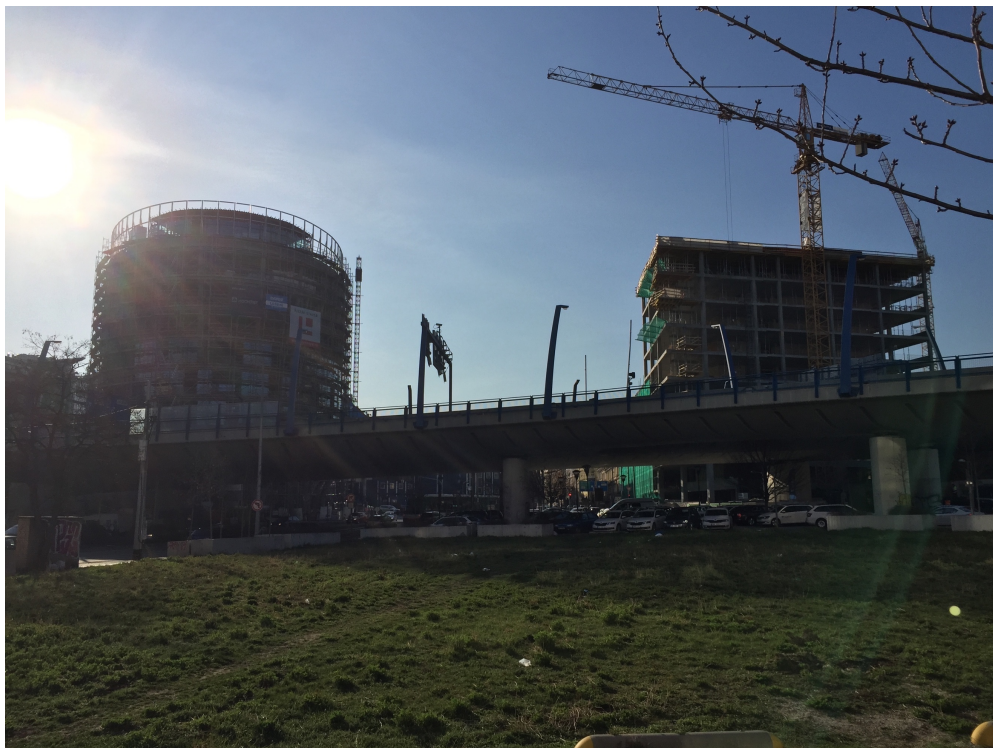
Obr. 20: Nové hmotové uspořádání dle schválené dokumentace (vlastní fotografie)
