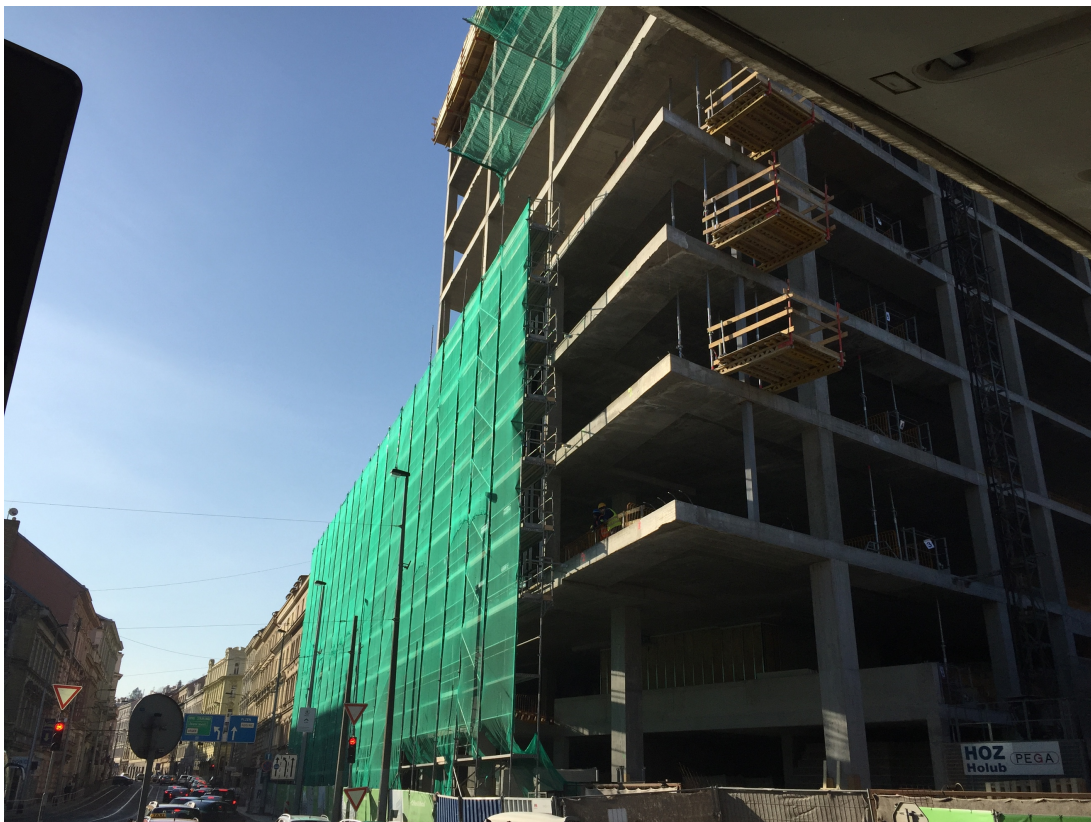
Obr. 19: Realizovaná protihluková a protiprašná opatření (vlastní fotografie)
