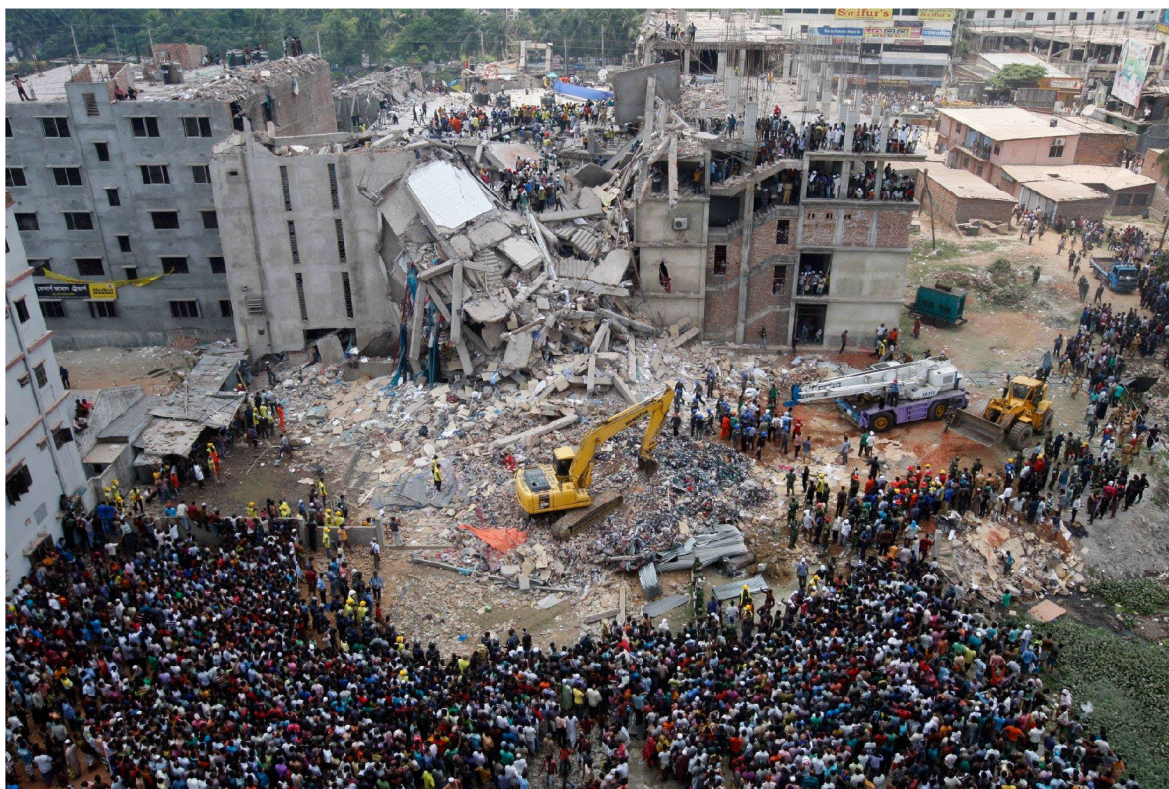
Obrázek 3 - Zhroutení budovy Rana Plaza 52
