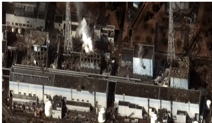
Obrázek 4 - Satelitní pohled na čtyři poškozené reaktorové budovy
