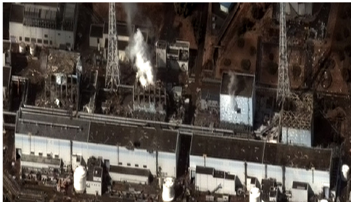
Obrázek 4 - Satelitní pohled na čtyři poškozené reaktorové budovy
